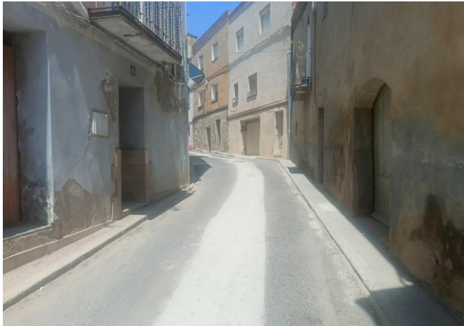
Vista general del C/Calvari (banda nord - zona a reurbanitzar)
