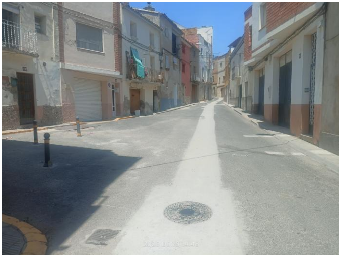
C/Calvari (punt inici projecte reurbanització – banda sud)
