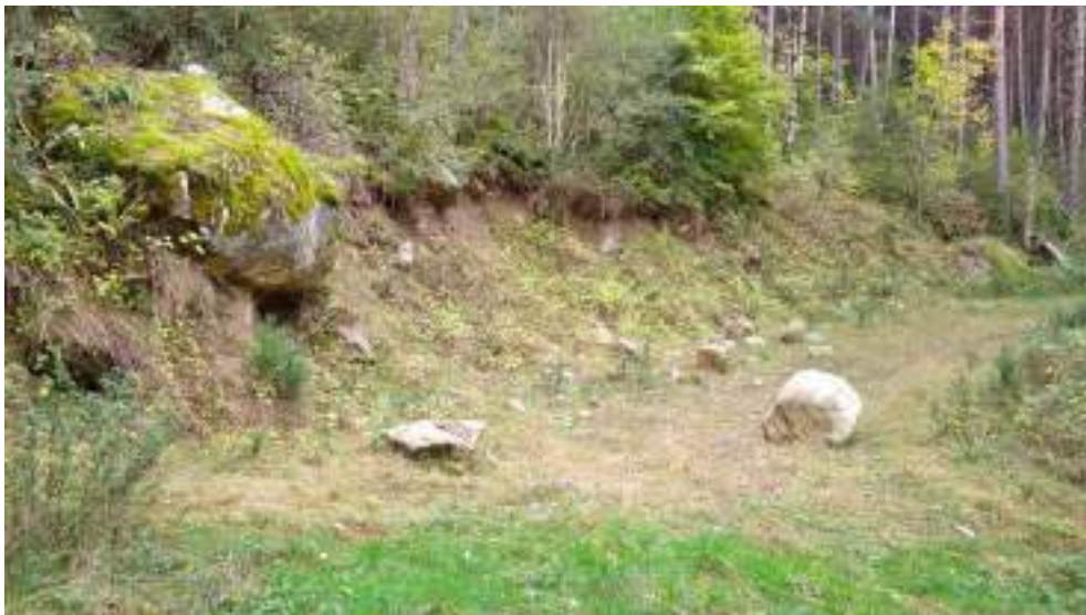
Fotografia 5. Eixamplament del radi de gir i construcció d'escullera de 32m 3 (codi sector 4)
