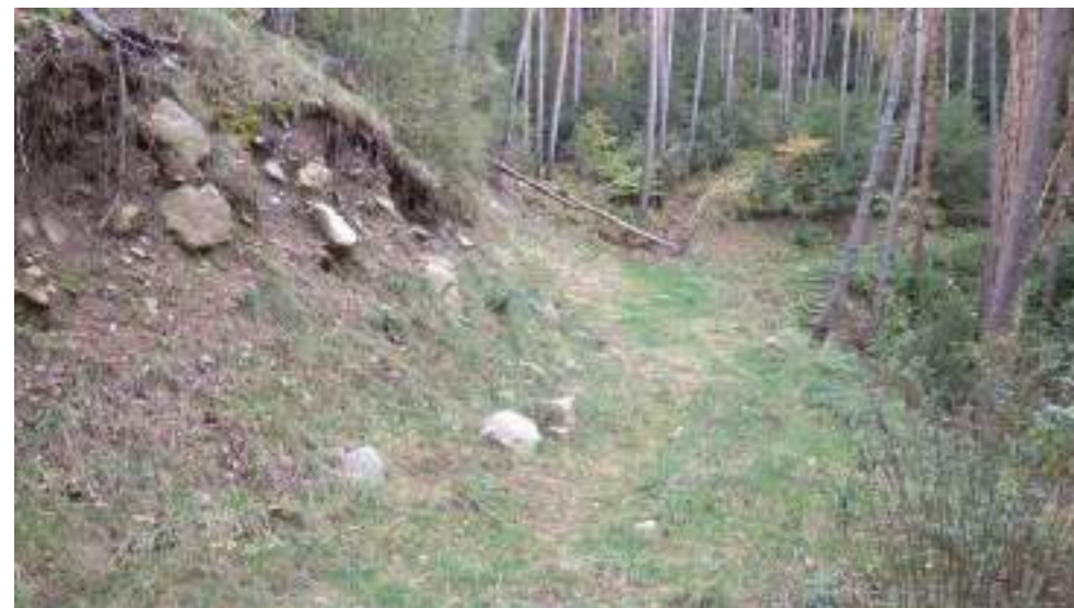
Fotografia 4. Eixamplament de la pista i construcció d'escullera de 40m³ (codi sector 3)
