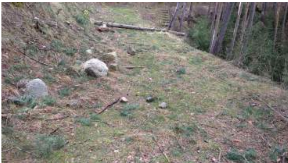
Fotografia 9, 10, 11, 12. Arranjament de la pista (eliminació del regenerat de pi de la plataforma i del talús, eliminació d'arbres i roques caigudes, explanació de la plataforma, construcció de trencaigües (codi sector 7)
