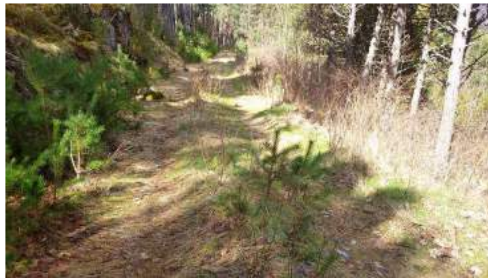
Fotografia 8. Arranjament de la pista (eliminació del regenerat de pi de la plataforma i del talús (codi sector 7)
