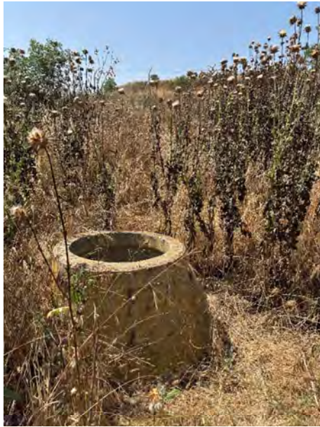
Arqueta de connexió d'aigües pluvials i canonada a canviar (costat nord del camí)
