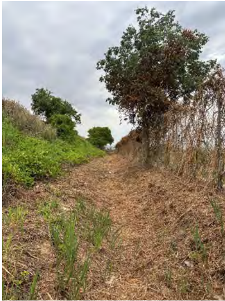
Cuneta perimetral extrem nord
