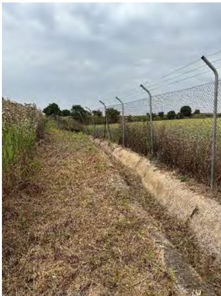
Cuneta perimetral extrem nord-oest
