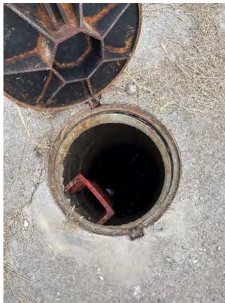
Arqueta de control 1 de connexió d'aigües pluvials (extrem est)
