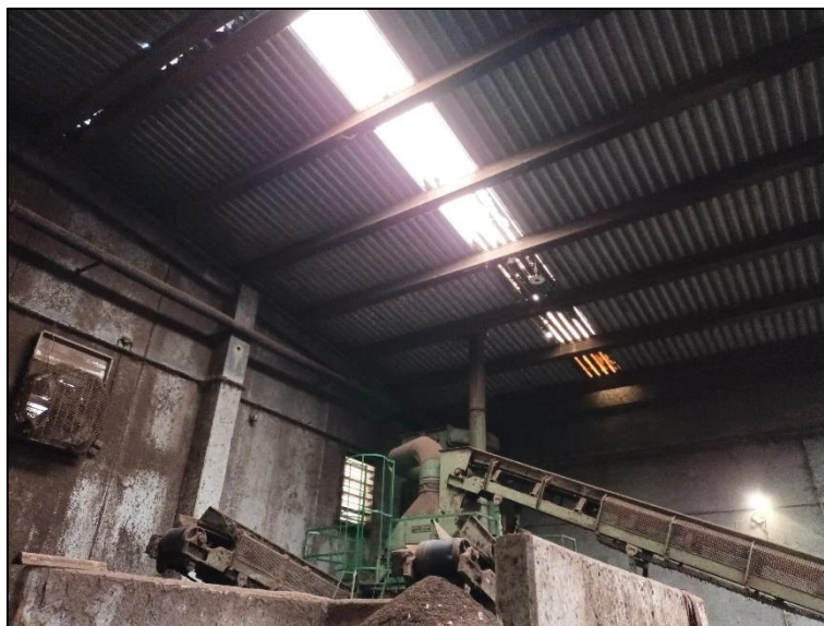
Figura 8. Imatge interior de la coberta. Font pròpia.
