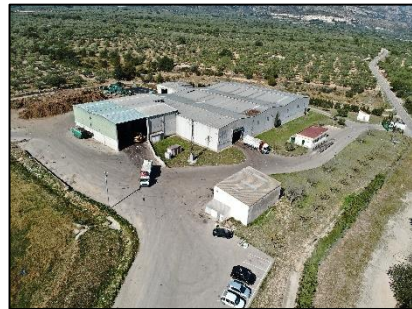
Figura 2. Fotografia aèria de la planta de compostatge. Font: COPATE.
