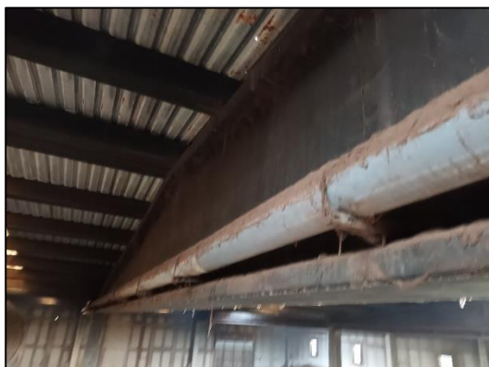
Figura 11. Imatge interior de la coberta. Font pròpia.
