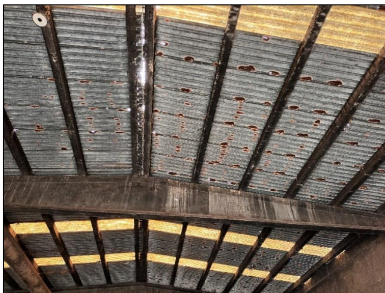
Figura 7. Imatge interior de la coberta. Font pròpia.
