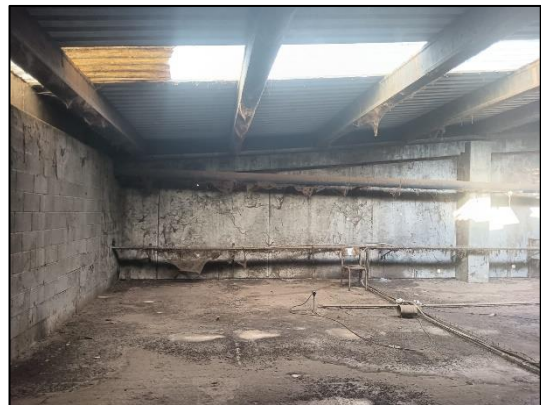
Figura 4. Imatge interior de la coberta. Font: COPATE.
