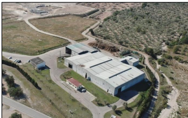
Figura 2. Fotografia aèria de l'estat actual de la coberta de la planta. Font: COPATE.
