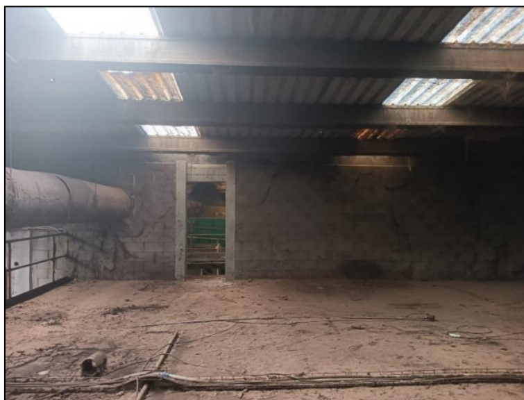
Figura 6. Imatge interior de la coberta. Font: COPATE.
