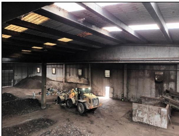
Figura 3. Imatge interior de la coberta. Font pròpia.
