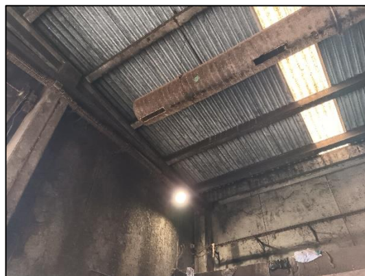
Figura 8. Imatge interior de la coberta. Font pròpia.
