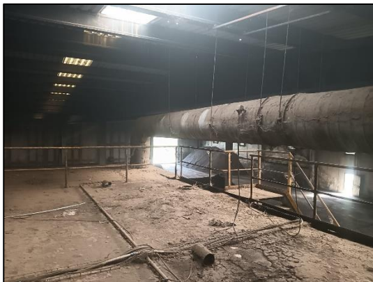
Figura 3. Imatge interior de la coberta. Font: COPATE.
