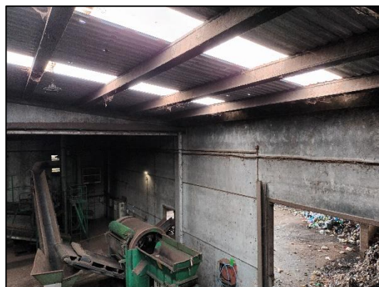
Figura 12. Imatge interior de la coberta. Font pròpia.
