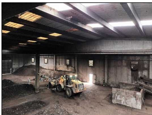
Figura 13. Imatge interior de la coberta. Font pròpia.
