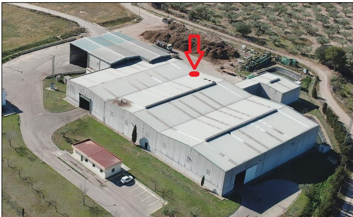
Figura 21. Imatge exterior de la coberta, amb indicació aproximada de la situació d'aquesta trapa. Font de la fotografia aèria: COPATE. Elaboració pròpia.
