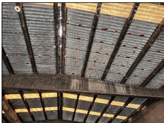
Figura 7. Imatge interior de la coberta. Font pròpia.
