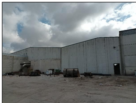
Figura 16. Fotografia exterior de la planta de compostatge. Font pròpia.
