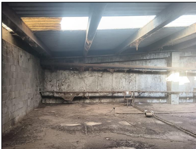
Figura 22. Imatge interior de la coberta, on aproximadament s'instal·laran les escales i la trapa. Font: COPATE.
