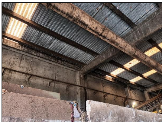
Figura 9. Imatge interior de la coberta. Font pròpia.
