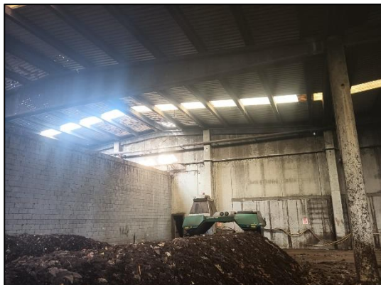
Figura 5. Imatge interior de la coberta. Font pròpia.
