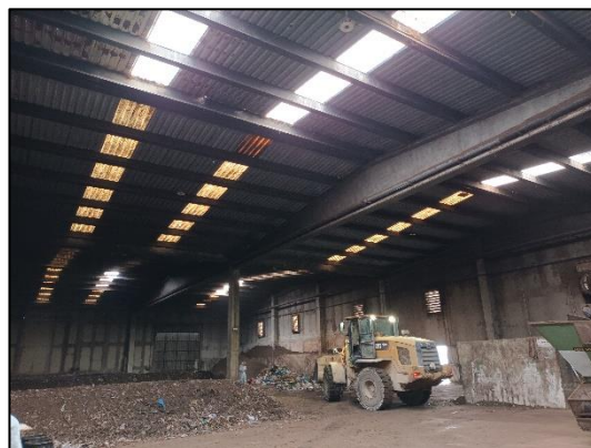
Figura 10. Imatge interior de la coberta. Font pròpia.
