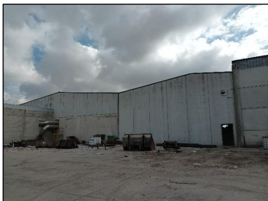
Figura 15. Fotografia exterior de la planta de compostatge. Font pròpia.
