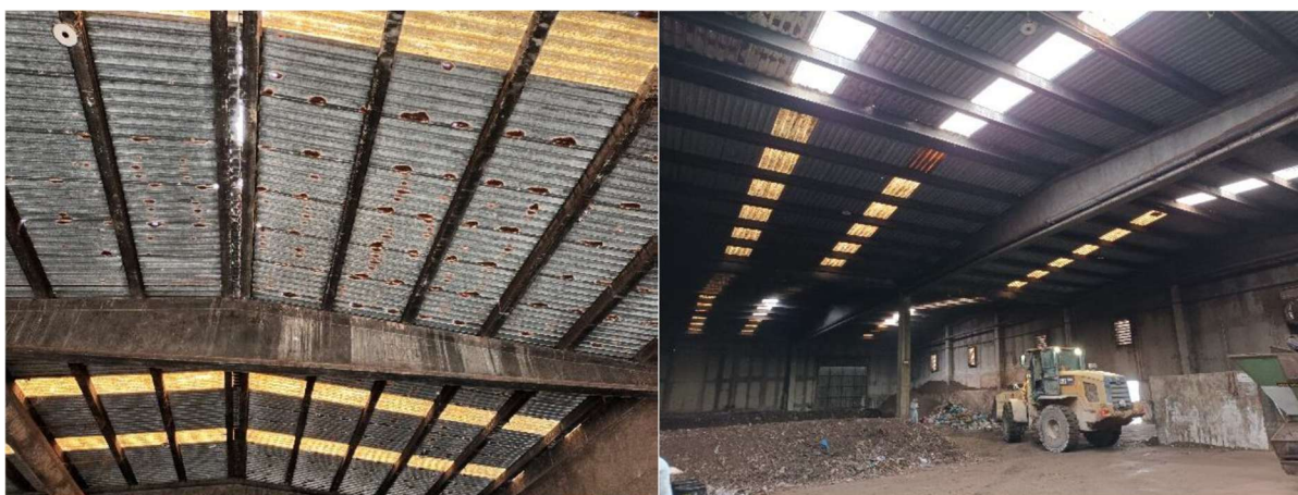
Fig. 6.- Coberta de la planta de compostatge de Mas de Barberans.
