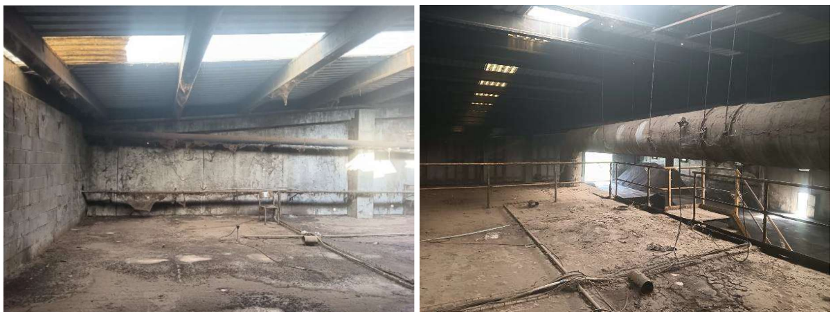
Fig. 9.- Coberta de la planta de compostatge de Mas de Barberans.
