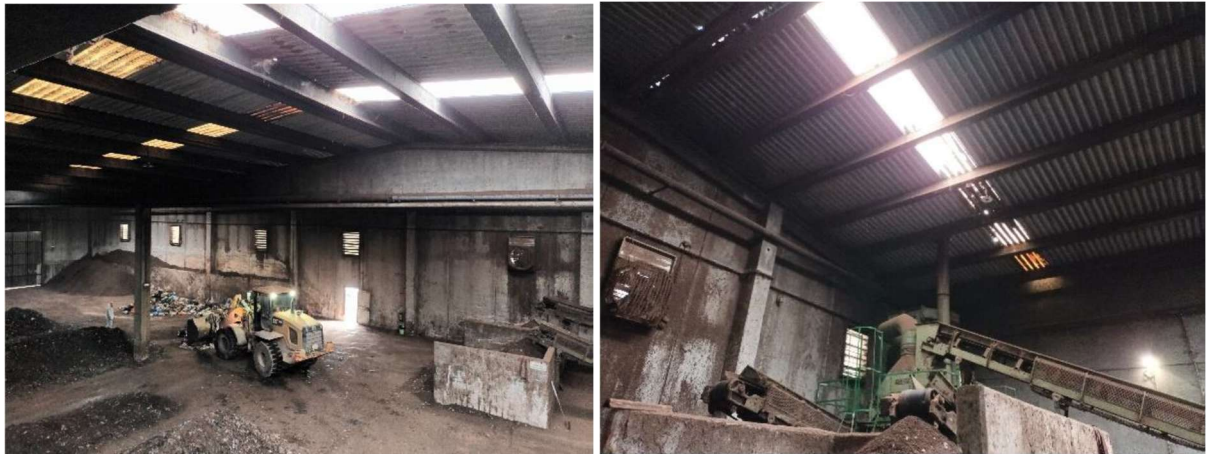
Fig. 8.- Coberta de la planta de compostatge de Mas de Barberans.
