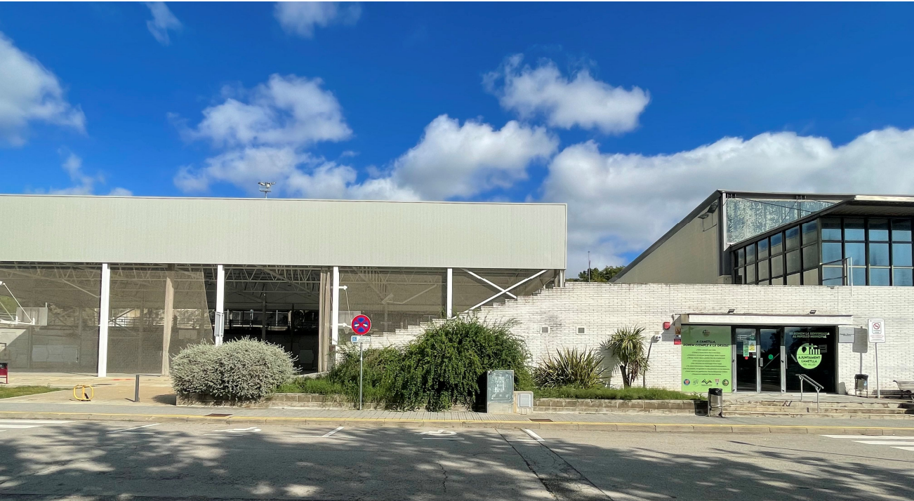
Fotografies de L'edifici existent i àmbit d'ampliació:
