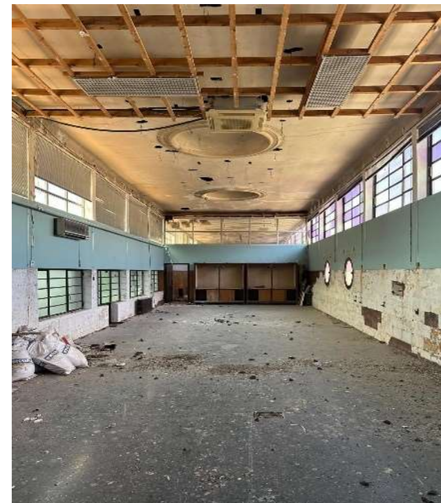
Fig. 3 Imatge de l'espai en planta primera: El cel ras tapa una estructura com la del sostre de planta baixa de bigues
