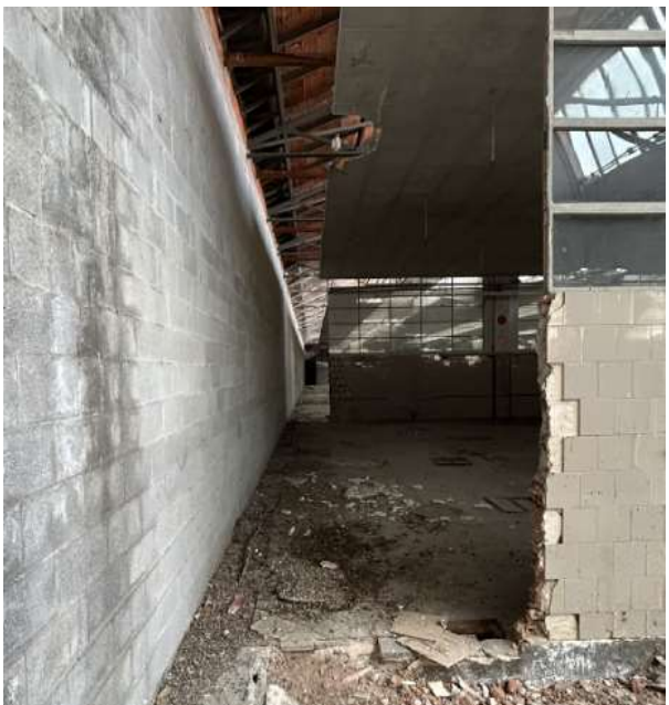
Fig. 36 :Imatge de divisòries de bloc de formigó fetes amb posterioritat, i que desvirtuen la concepció original
