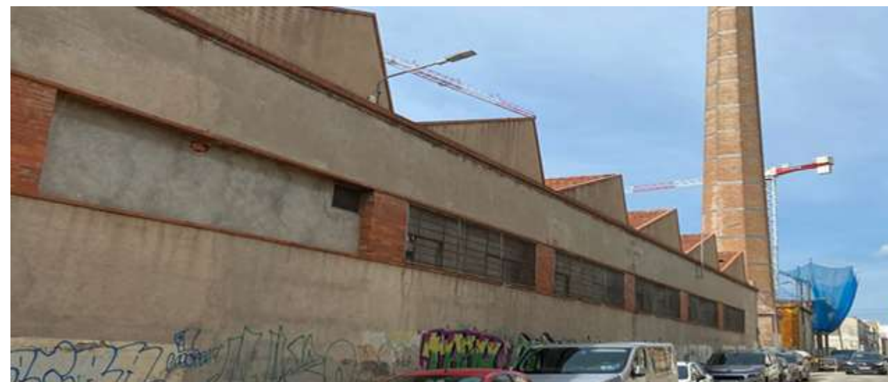
Fig. 30: Imatge actual de l'edifici de producció des de la Gran Via, s'aprecia l'ocultació del perfil en dent de serra, per donar una expressió més urbana, o les cornises a sardinell amb la finestra longitudinal original, tapiada.
