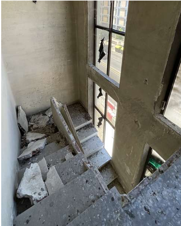
Fig. 50: Imatge de l'arribada de l'escala de l'edifici torre a planta segona.
