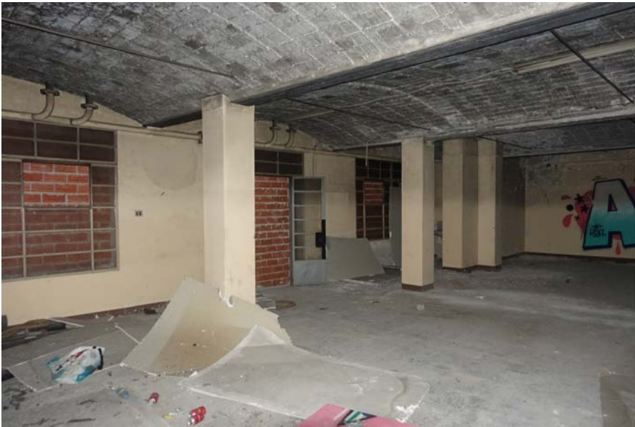
F20. SALA, P.BAIXA, EDIFICI ANNEXE
