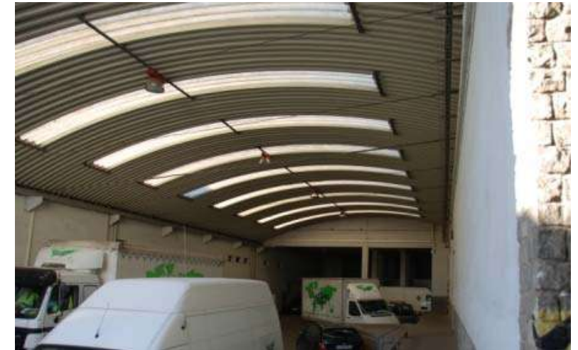
Coberta metàl·lica del pati central i dels molls de càrrega
