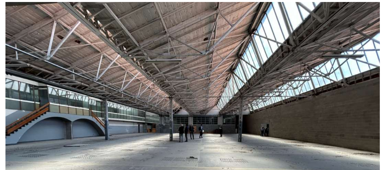
Fig. 24: La coberta vista des de l'interior de les naus, verifica la formació de la mateixa per un encadellat ceràmic, i directament al damunt, la teula plana ceràmica col·locada amb morter de calç.
