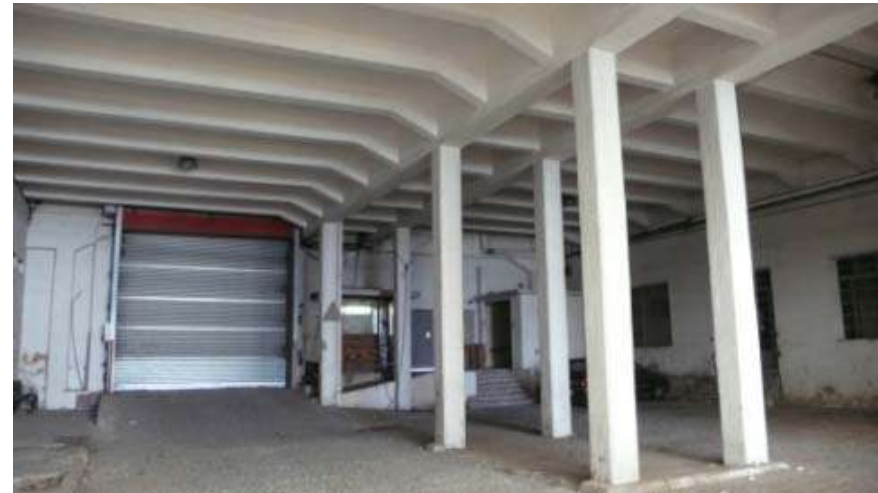
Porta d'accés per a camions. Estructura porticada de formigó
