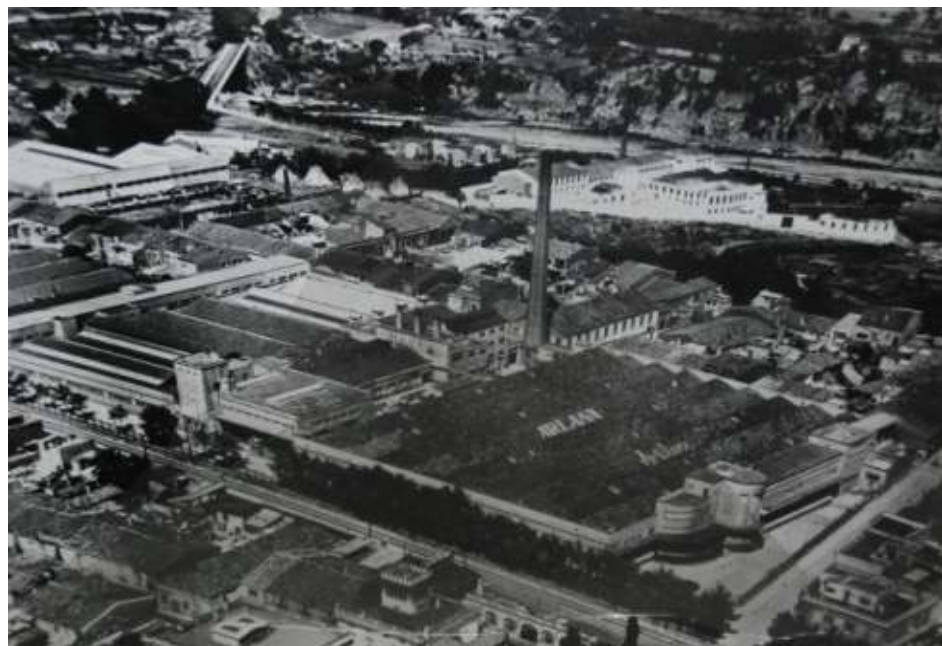
Vista aèria de la fàbrica Artèxtil. 1965/AHS
