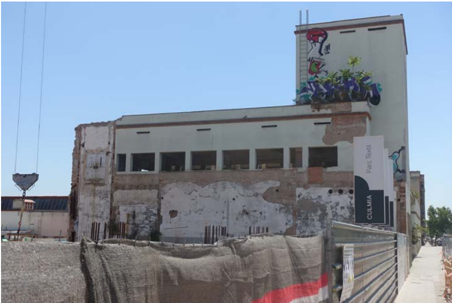
F05. ALÇAT MITGERA EDIFICI ANNEXE
