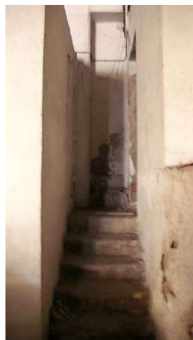
Accés a la torre
