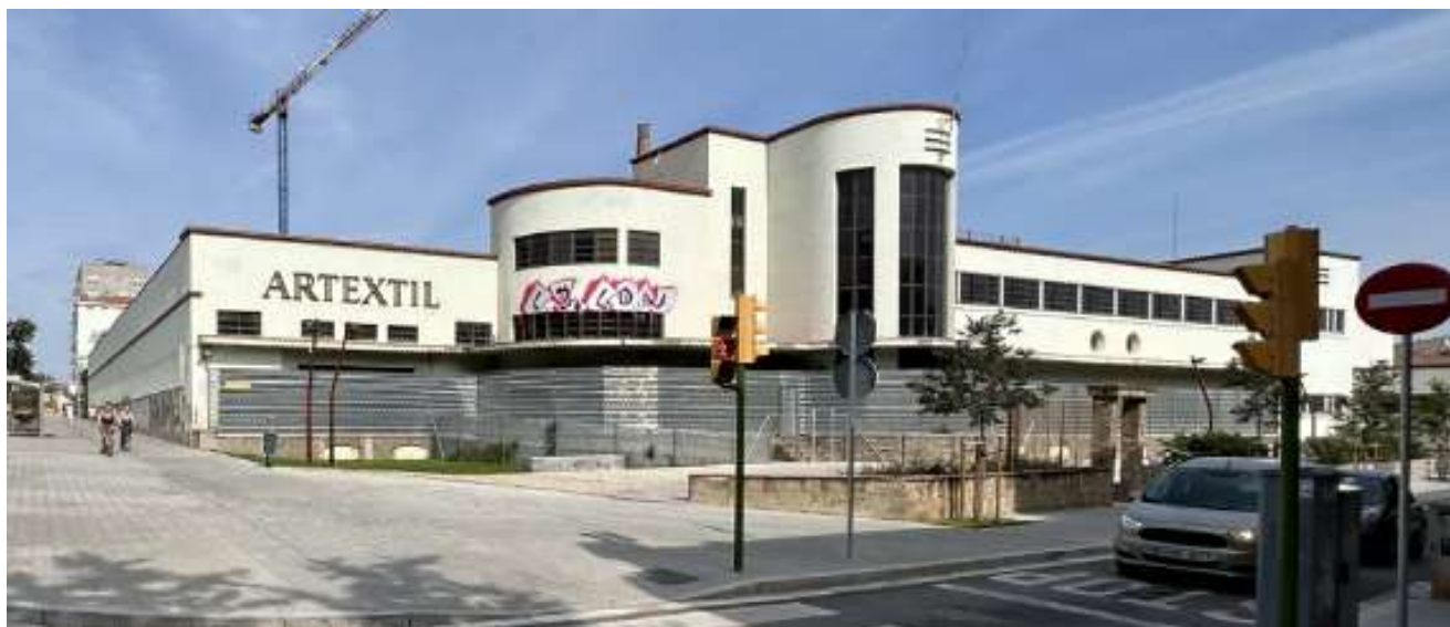
Fig. 28: Imatge actual del cos d'administració s'observa el manteniment de la volumetria original, però amb modificacions significatives en la composició de les fusteries o modificació del color original.
