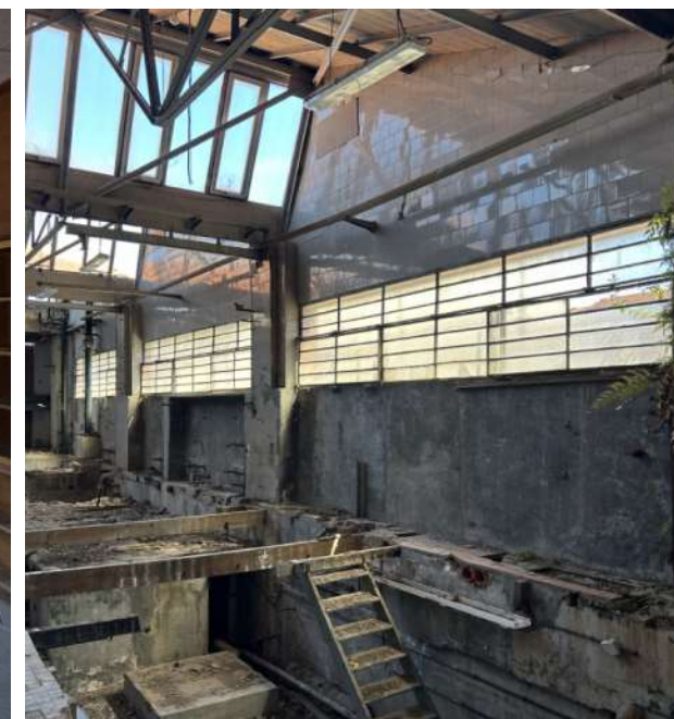
Fig. 42: Imatge de les fusteries originals de diversos elements rectangulars que conformen la unitat, i realitzats a base de perfils de ferro i vidres translúcids.
