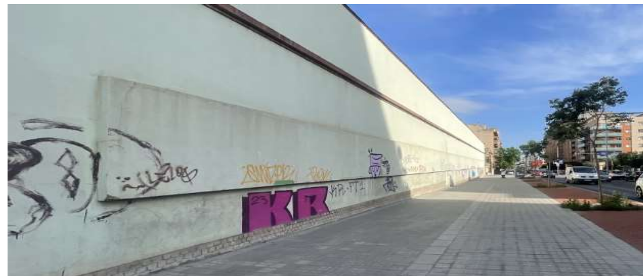
Fig. 29: Imatge actual de l'edifici de producció des de la Gran Via, s'aprecia l'ocultació del perfil dent de serra, per donar una expressió més urbana, i les cornises a sardinell i la finestra longitudinal original, tapiada.
