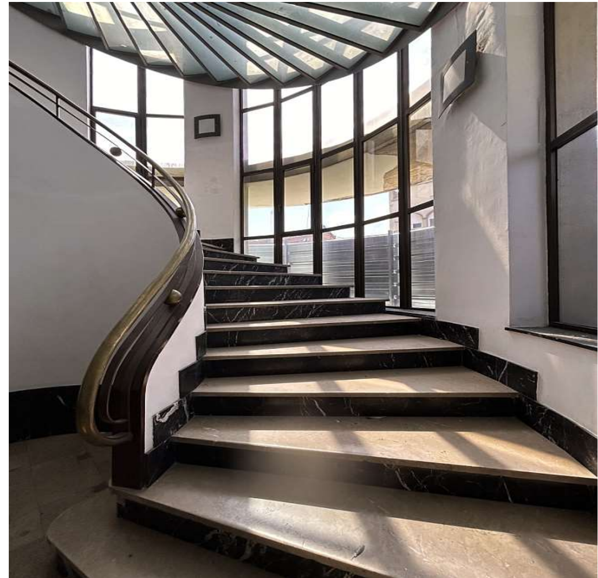
Fig. 46: Vista de l'arrencada de l'escala noble de l'edifici d'administració, amb voluntat d'escala noble, tant pel dissenys com per el tractaments dels materials de llautó, marbres o sòcols.
