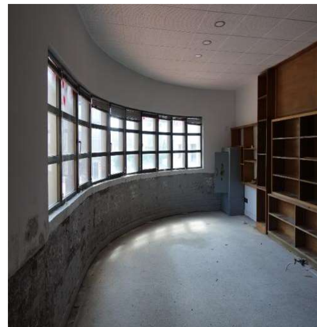
Fig. 41: Tancament de nou d'alumini anoditzat bronze de la zona de direcció, simulant l'especejament dels tancaments originals. Envidrament senzill.
