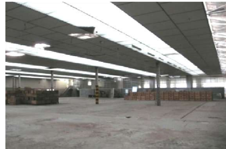
Vista de la nau principal amb el fals sostre col·locat
