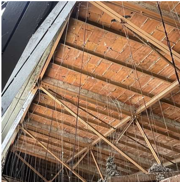
Fig. 25: Imatge del sostre de les encavallades on s'aprecia el tauler ceràmic recolzat sobre el sistema de corretges.
