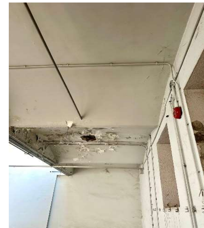
Fig. 13: Imatge d'un tram de sostre en planta primera, resolt amb bigues metàl·liques i voltes ceràmiques. Mateixa tipologia que en la planta soterrani.
