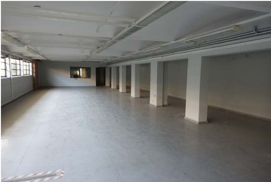
F15. SALA, P.BAIXA, EDIFICI OFICINES
