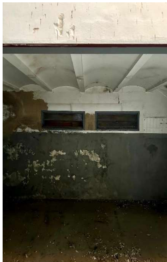
Fig. 14: Imatge d'un tram de sostre en planta primera, resolt amb forjat unidireccional de bigueta de formigó, que es veu en bon estat.
