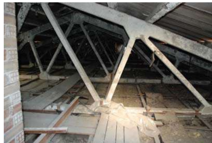
Part de l'encavallada de formigó
