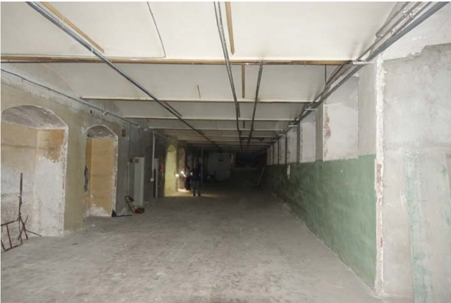
F13. SALA, P.SOTERRANI, EDIFICI OFICINES
