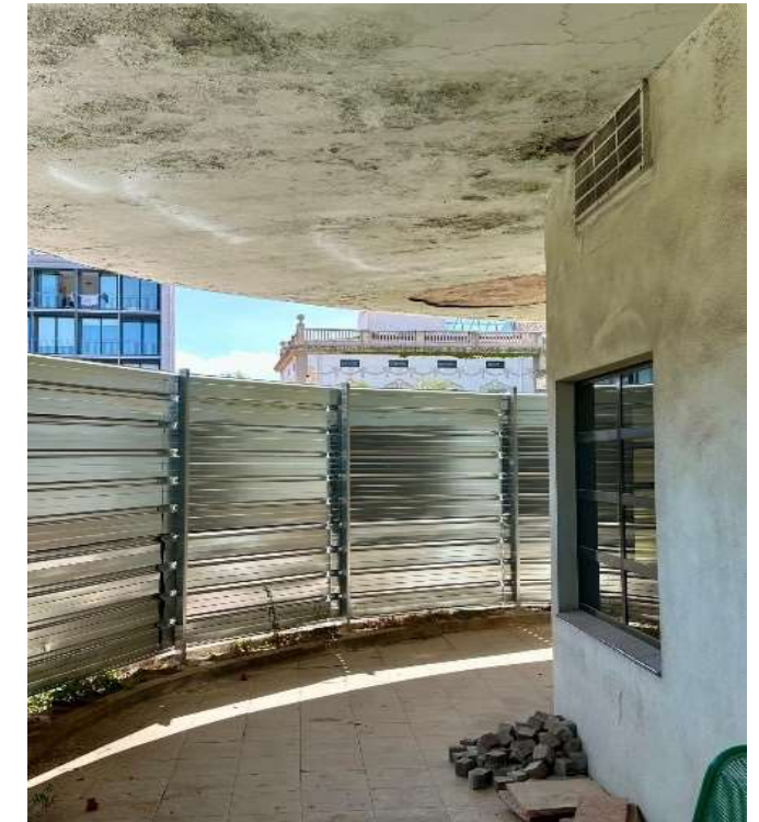
Fig. 2: Imatge del sostre de la marquesina volada en el carrer de Quevedo.
