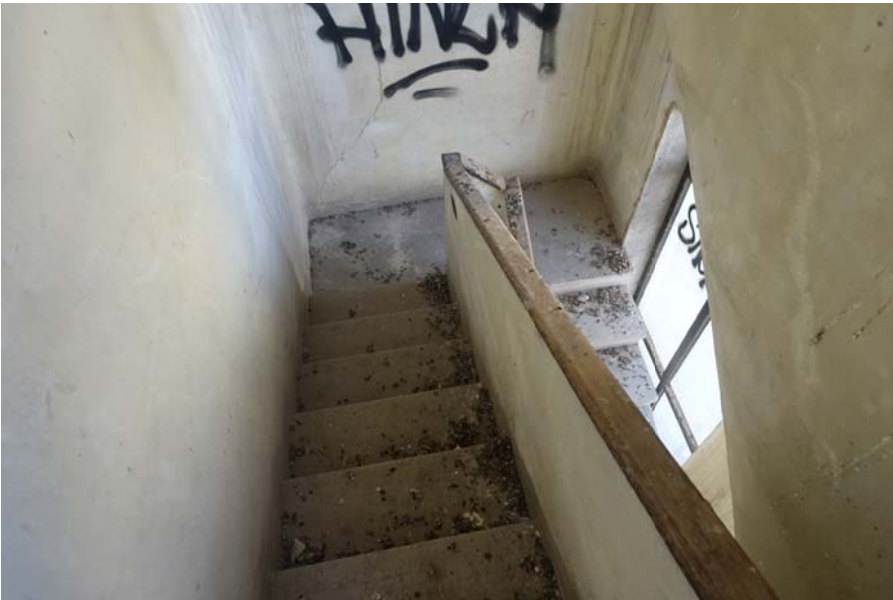
F22. ESCALA, EDIFICI ANNEXE
