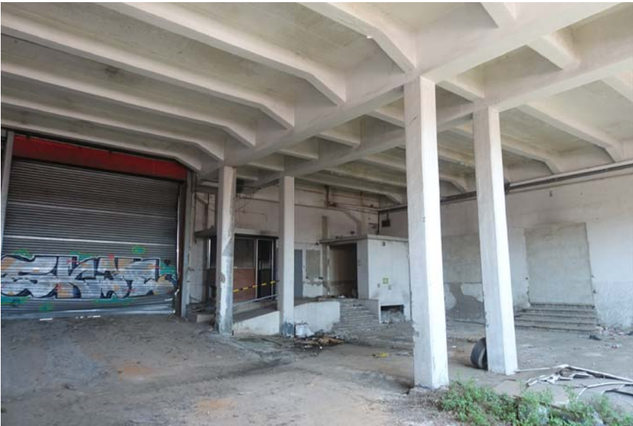
F19. ACCÉS, P.BAIXA, EDIFICI ANNEXE
