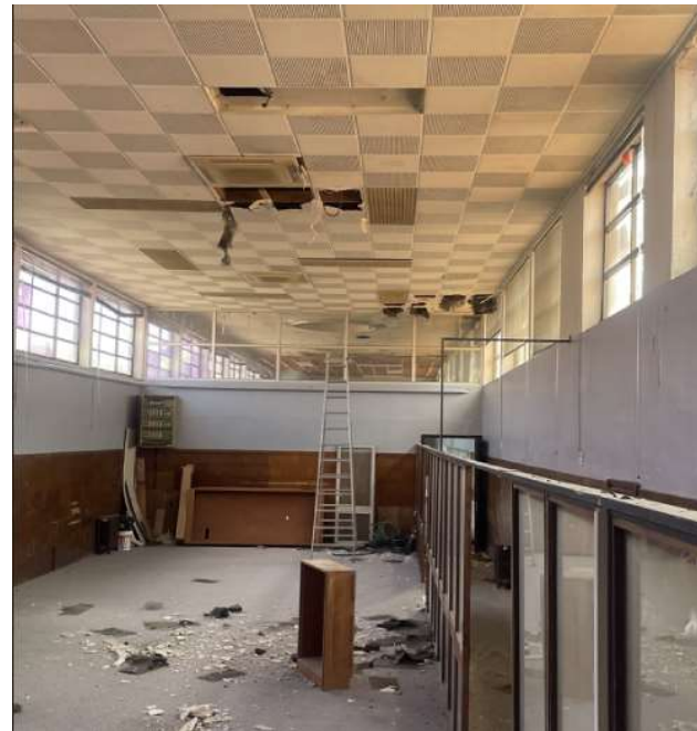
Fig. 45: Imatge del cel ras, més modern, fet per poder incloure instal·lacions de clima i d'enllumenat.
