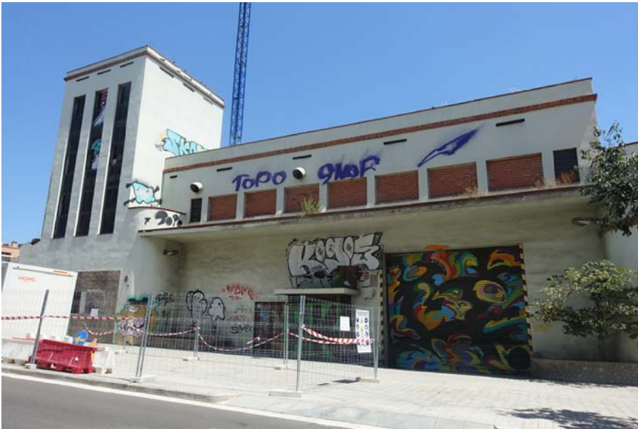
F02. ALÇAT GRAN VIA EDIFICI ANNEXE
