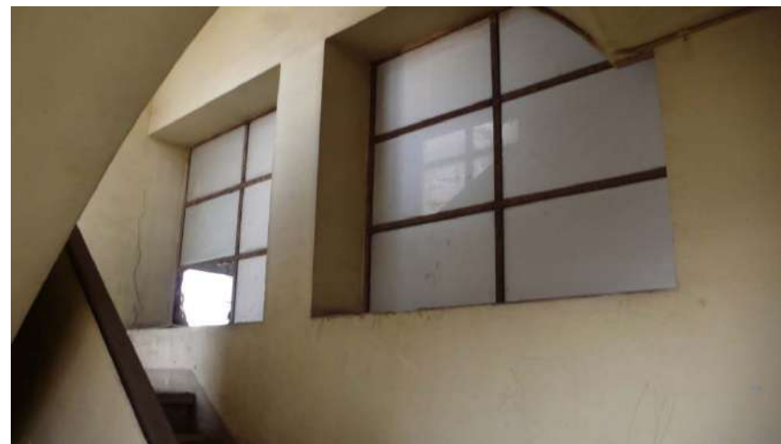
Finestres del vestidor dels treballadors a les escales
