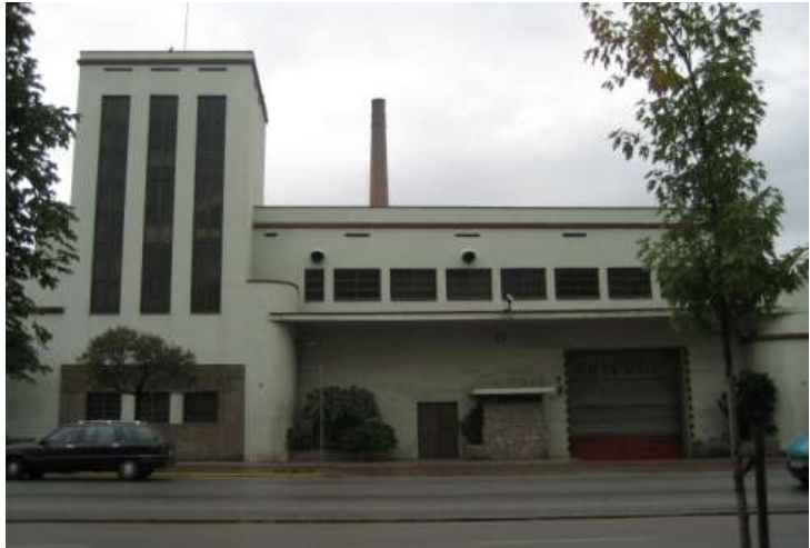
Entrada i façana del pati des de la Gran Via
