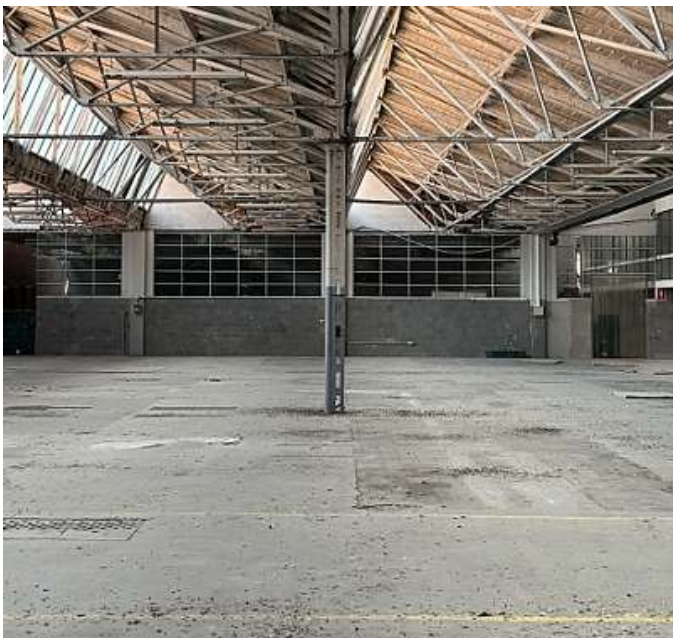
Fig. 35: Imatge de les divisòries originals, que conformen un sòcol inferior de protecció i una part superior vidriada, amb la mateixa composició d'envidrament que a les façanes, i dona unitat al conjunta
