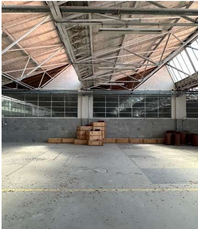
Fig. 9: Imatge de la trobada de l'estructura amb un mur interior.
