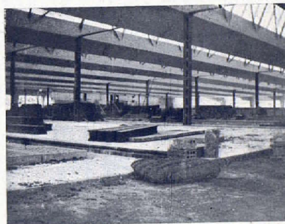
Nave de telares
