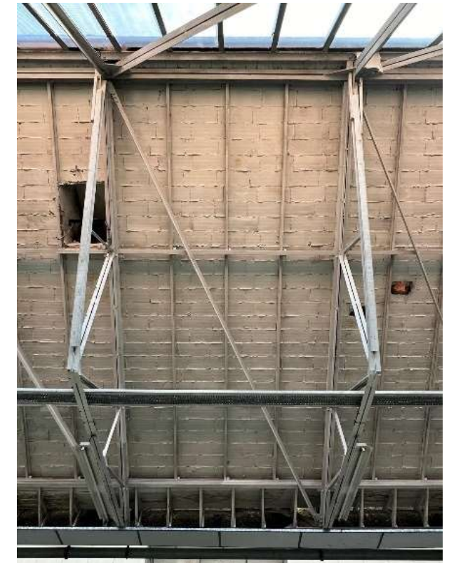
Fig. 8 Imatge zenital de la coberta: Gelosies principals, corretges entrebigat i encadellat ceràmic.:
