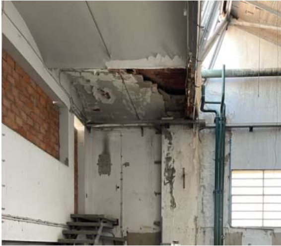
Fig. 22 Detall de voltes esfondrades
