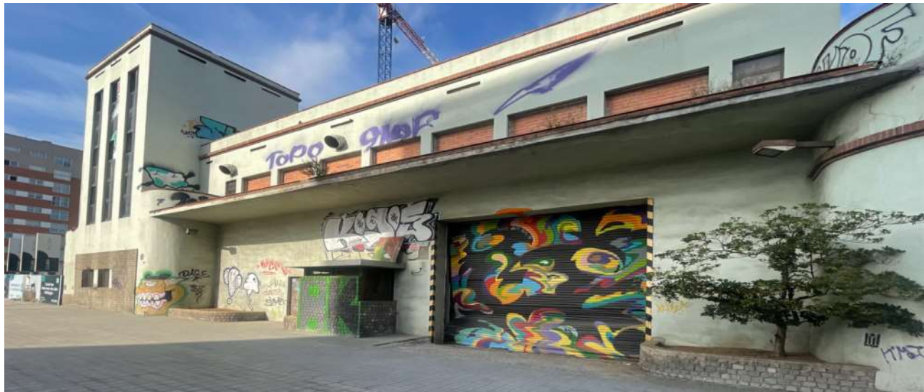
Fig. 31: Imatge actual de l'accés a l'interior del pati d'illa i de l'edifici torre que manté els trets compositius de l'edifici representatiu d'administració.
