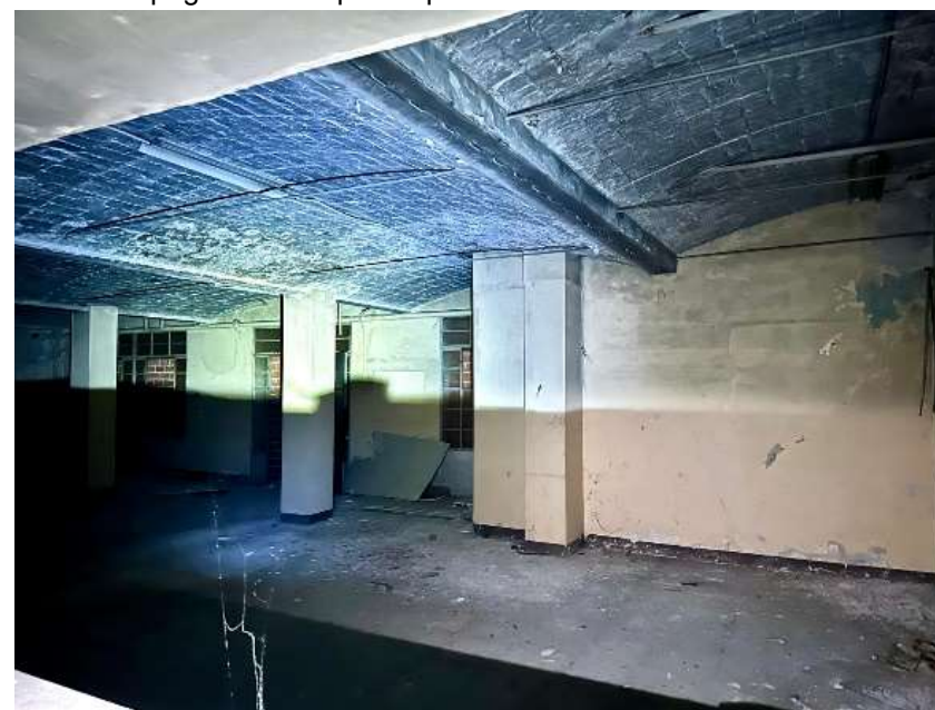
Fig. 18: Imatge de l'estructura en planta baixa: Pilastres, bigues metàl·liques i voltes de 3m entre bigues.
