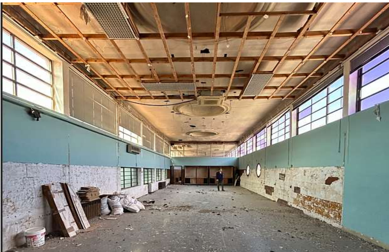
Fig. 33: Imatge de la sala gran d'exposicions i venda de l'edifici administratiu a la planta 1.
