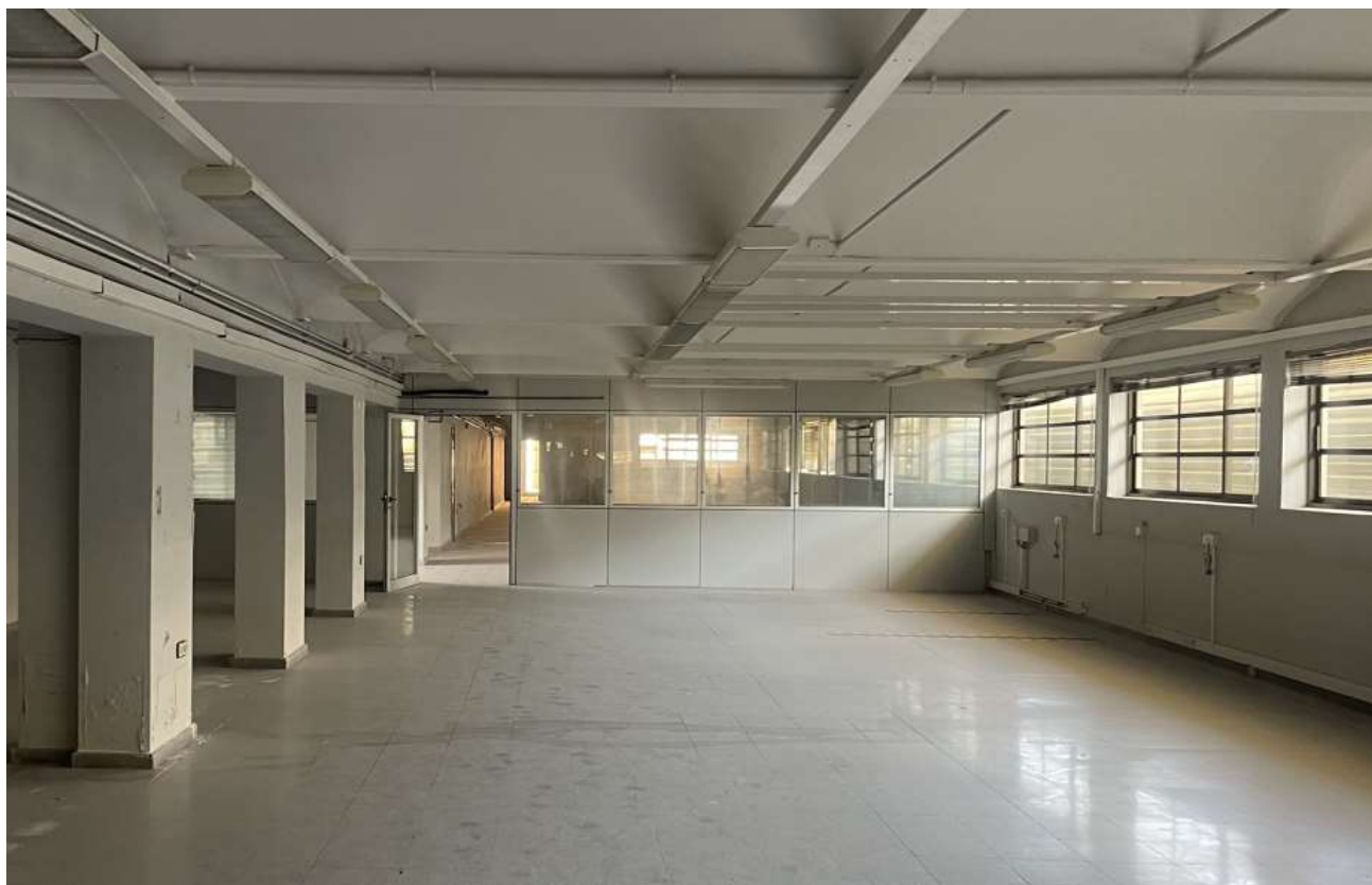
Fig. 34: Imatge de les sales d'administració de la PB, amb limitació d'alçada de sostre, sense cel ras.
