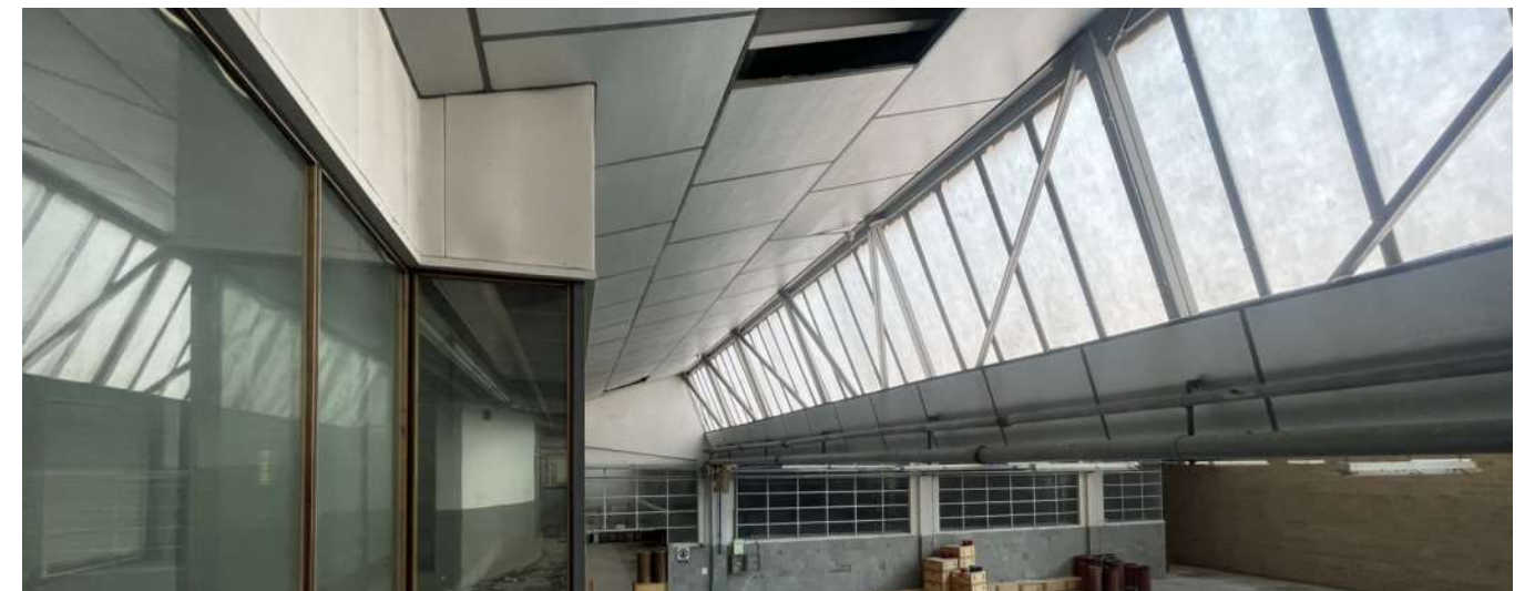
PART DEL CEL RAS ORIGINAL EXISTENT A LA DARRERA CRUJIA
