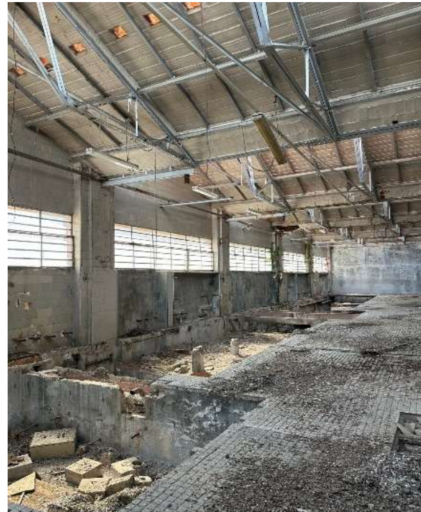
Fig. 10 Imatge de la trobada de l'estructura amb un mur de façana.
