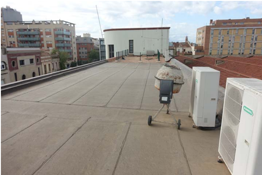
F18. TERRAT, EDIFICI OFICINES
