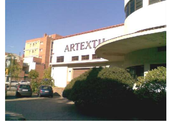
Detall del rètol "ARTEXTIL" a la cantonada C. Quevedo - Gran Via
