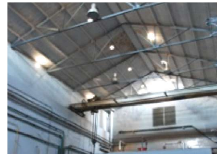
Vista de l'estructura metàl·lica de les últimes naus del C. Romeu
