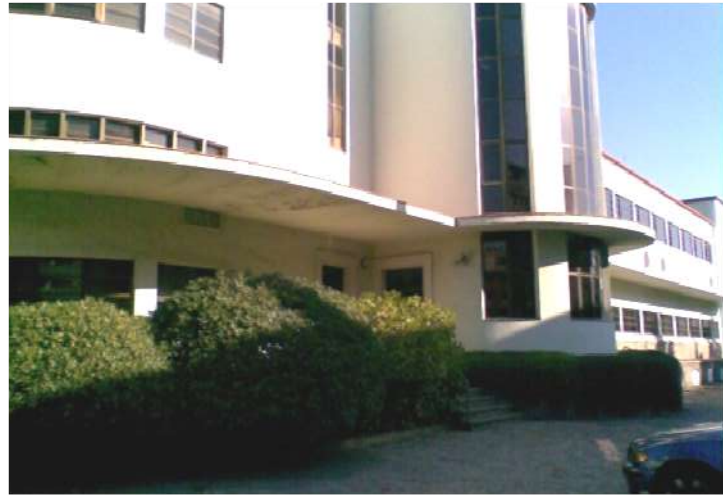
Vista del voladís de l'accés al cos d'oficines
