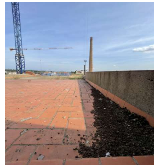
Fig. 21 Detall de l'acabat de rajola de Piera
