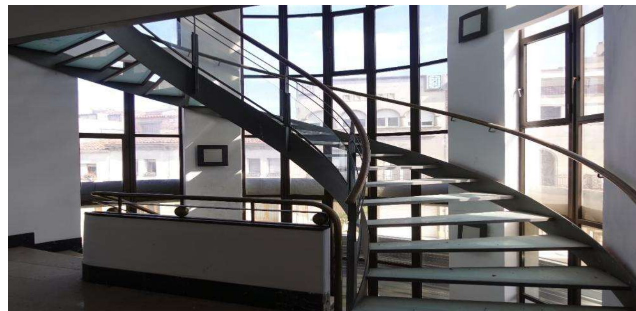
Fig. 43: Imatge corresponent al nucli vertical de comunicació, es troba l'element més singular de l'interior de l'Artèxtil. Es tracta d'una escala d'una tramada sencera realitzada amb platines d'acer i vidre, de formes molt treballades. No és un element original del projecte.. El tancament d'aquest nucli és a base de fusteria d'alumini anoditzada amb vidre de càmera, dels primers probablement col·locats als anys 70'.
