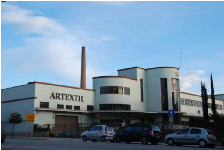
Façana del cos d'oficines. Cantonada C. Quevedo - Gran Via
