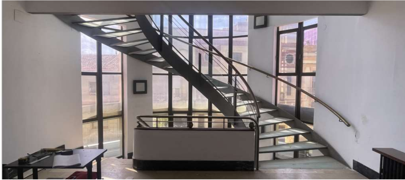
Fig. 47: Vista de l'arrencada de l'escala lleugera de nova creació, amb acabats força diferents del primer tram, que acusen la lleugeresa i verticalitat del cos cilíndric.
