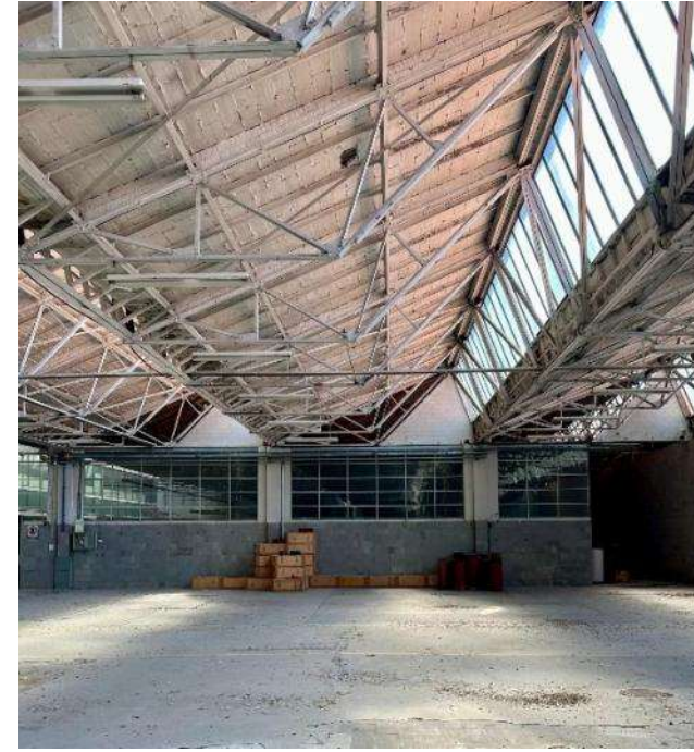
Fig. 5. Imatge general de l'estructura amb les gelosies triangulars entre encavallades principals vistes en alçat.
