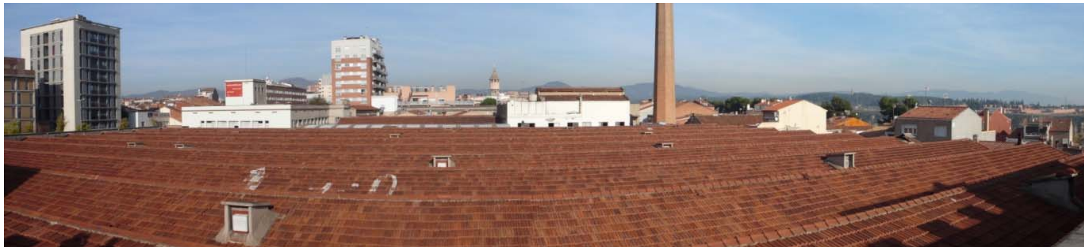
Vista de la coberta de teula ceràmica de la nau principal. S'intueix el traçat del text que es pot veure a les fotografies aèries antigues
