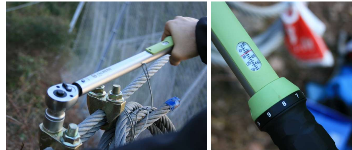
Figura 2. Foto detall de la comprovació de la força d'apretada en un premsacables amb clau dinamomètrica.
