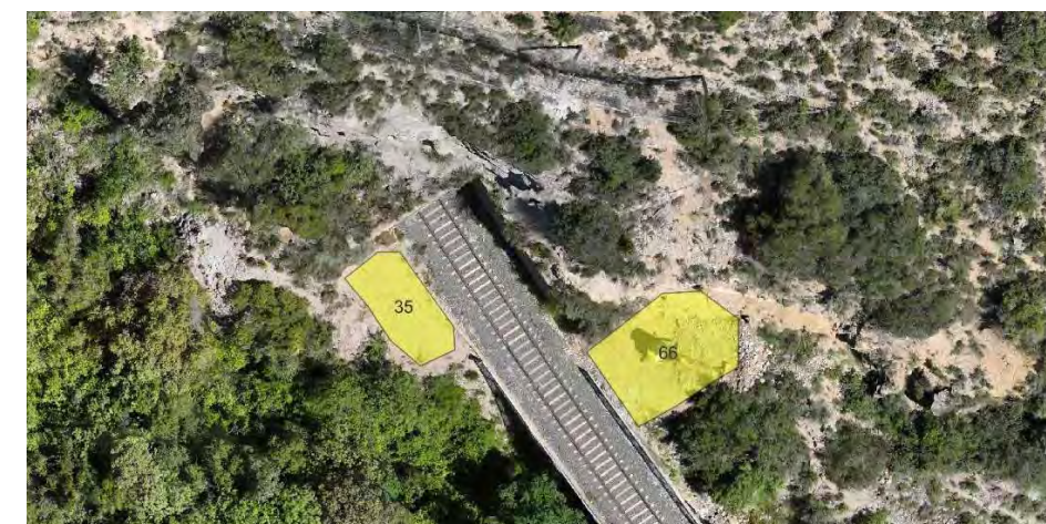
Figura 4. Zones d'aplec. Zona boca sud túnel 10.
