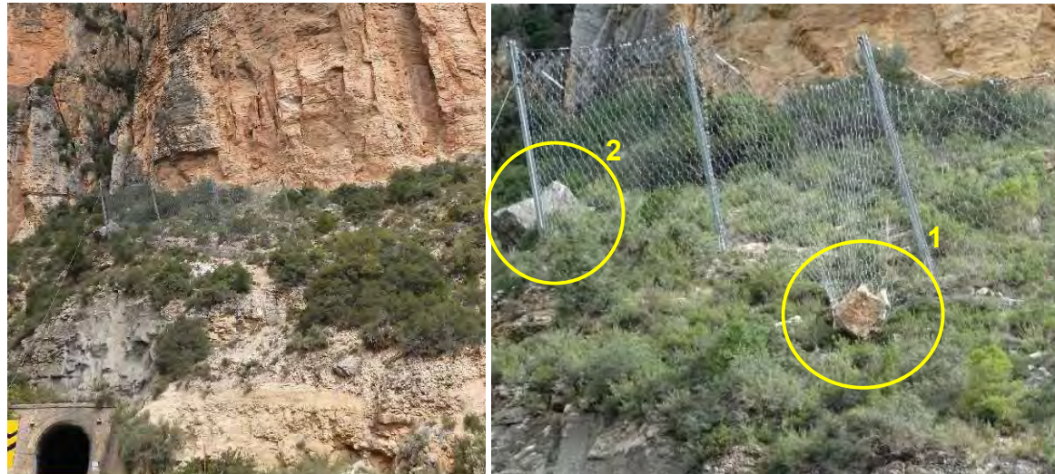
Figura 9. Bloc retingut a clau del túnel TU10. Imatge esquerra ortofotografia de l'any 1997 i fotografia dreta detall actual del bloc.
