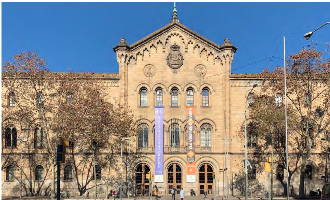
Vista actual de la façana de l'edifici amb pancartes
