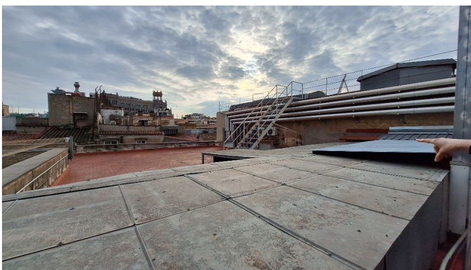
F16. Coberta del Palau Mauri i Finestres
