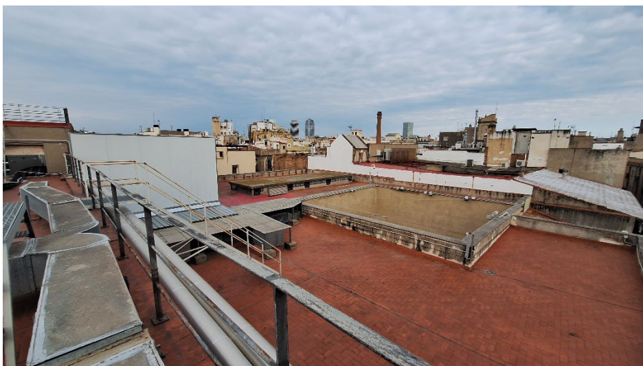
F14. Coberta del Palau Mauri i Finestres
