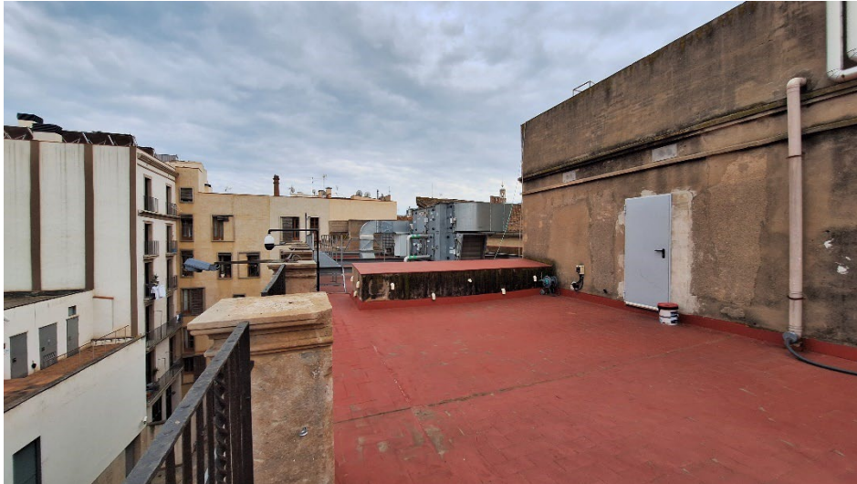
F13. Coberta del Palau Meca
