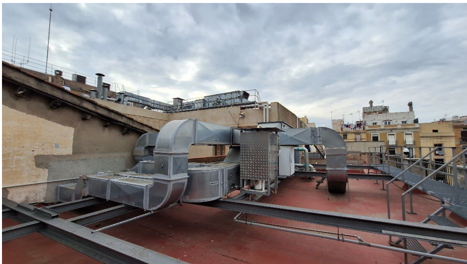
F12. Coberta del Palau Meca
