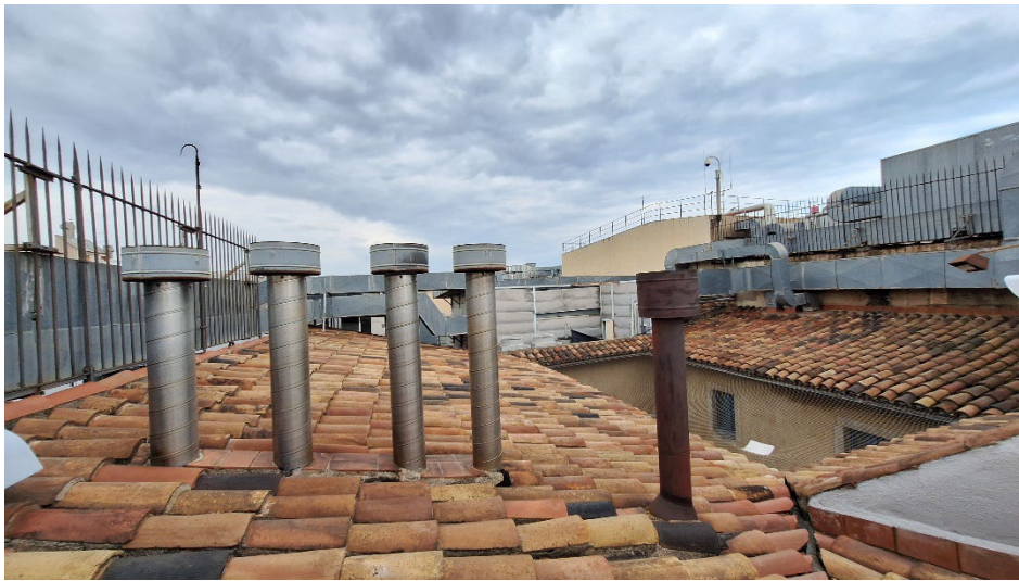
F6. Coberta del Palau Castellet
