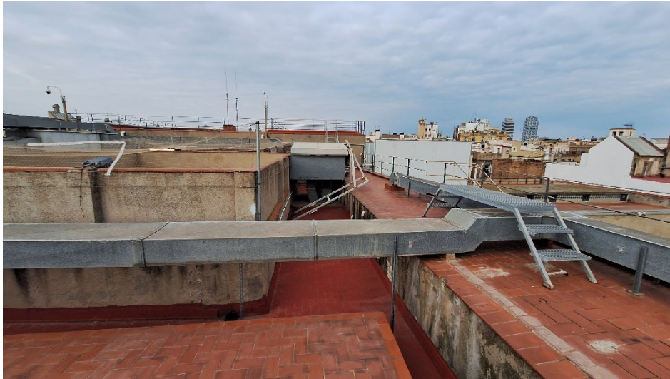
F10. Coberta del Palau Meca
