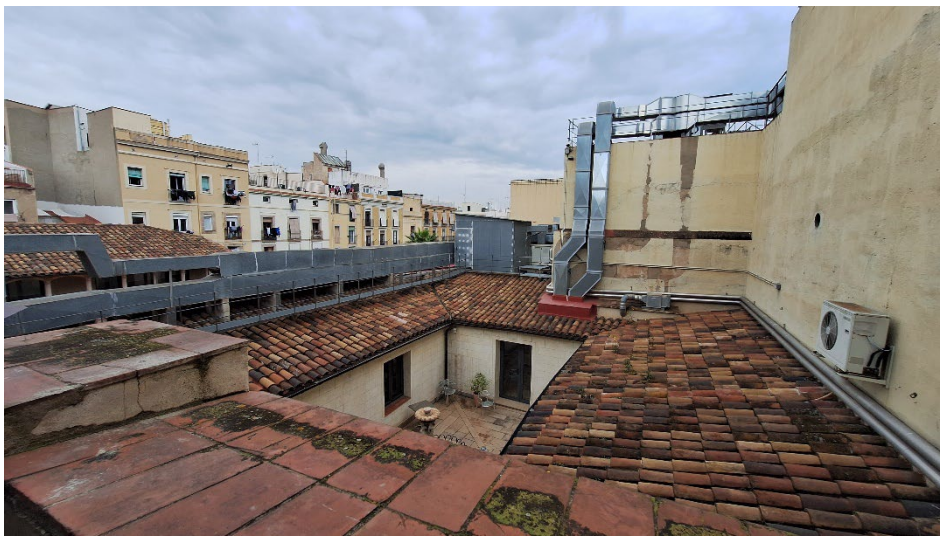
F7. Coberta del Palau Castellet
