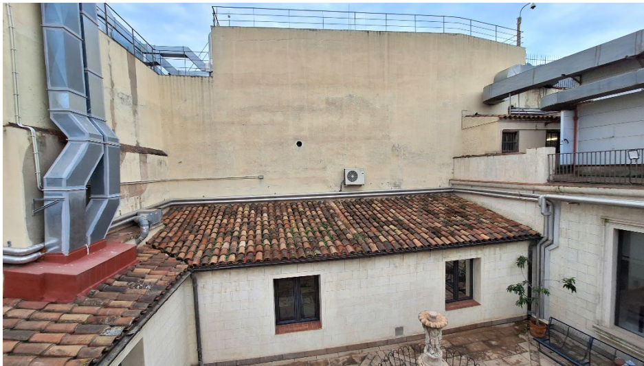
F9. Coberta del Palau Castellet
