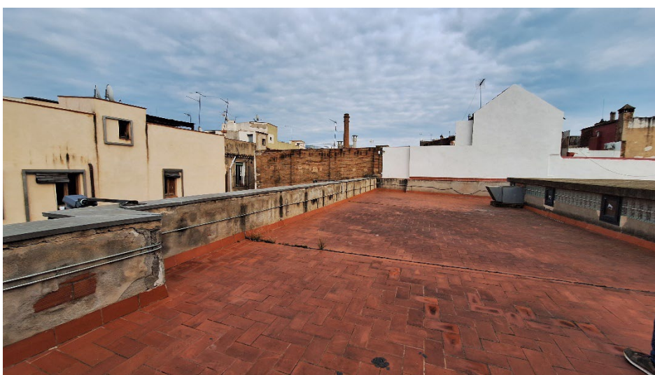
F15. Coberta del Palau Mauri i Finestres
