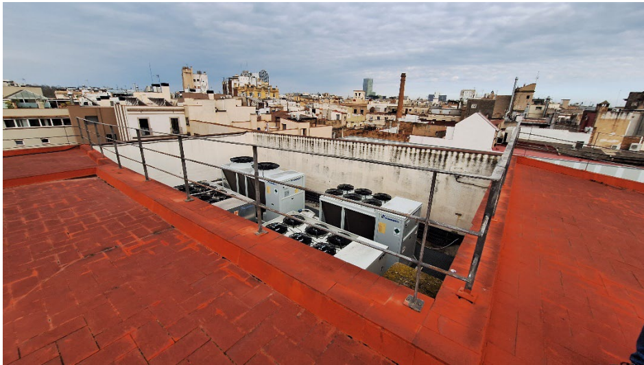
F11. Coberta del Palau Meca
