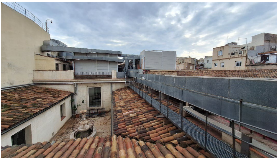
F8. Coberta del Palau Castellet
