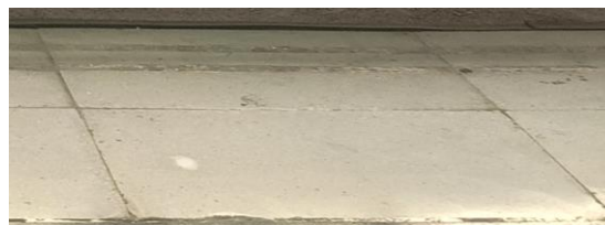
Figura 5: Imatge de les rajoles de vora d'andana
