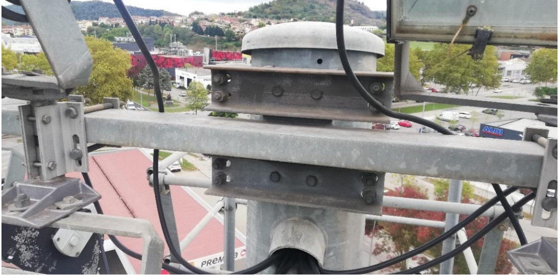
Fotografia torre detall creueta
