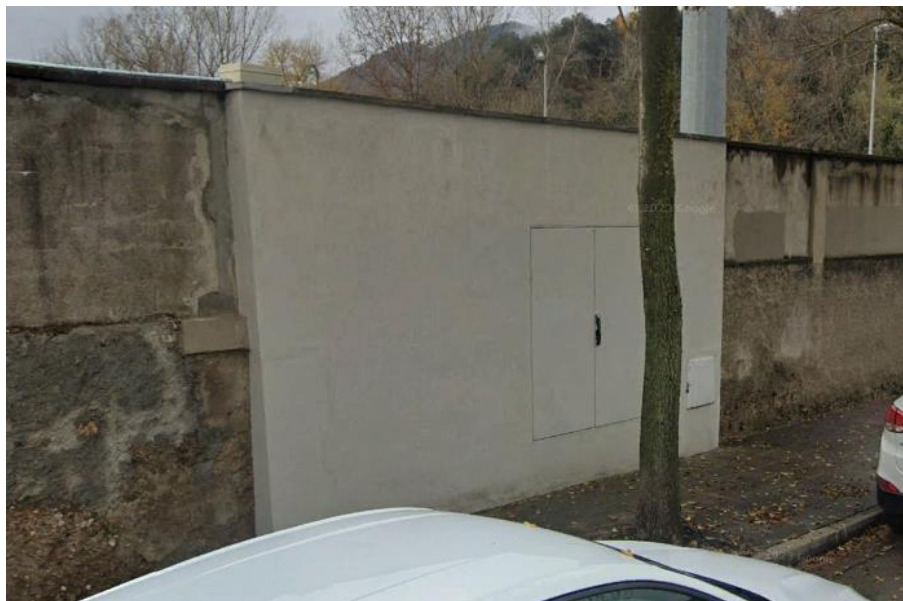
Fotografia ubicació instal·lació d'enllaç.
