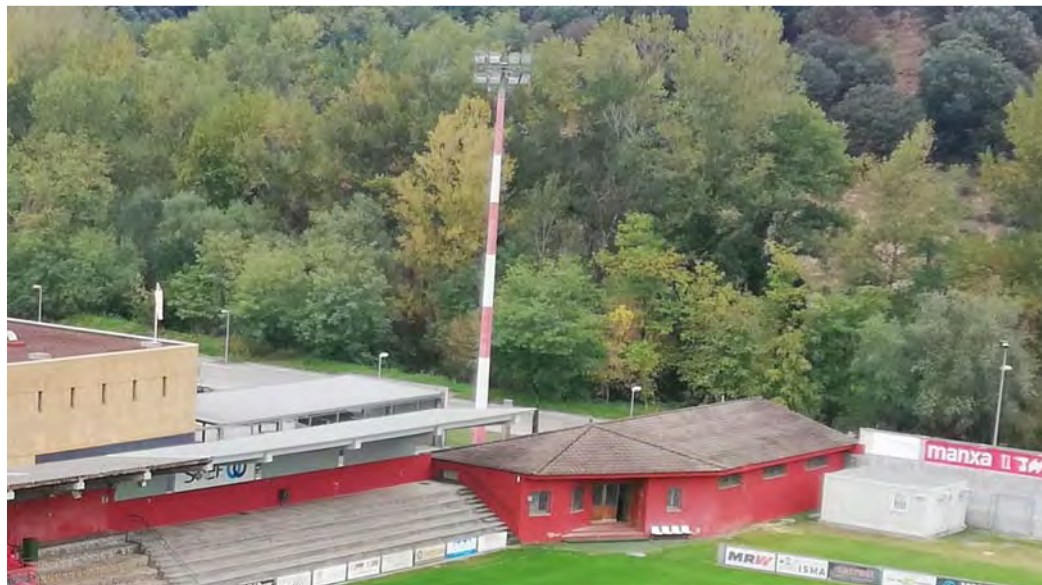
Fotografia torre 25 m amb projectors existents
