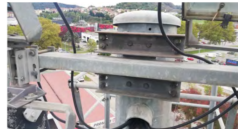
Fotografia suport perfil rectangular a la columna
