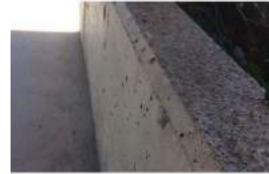
Figura 56. Imatge amb acabat bisellat coronació mur de formigó
