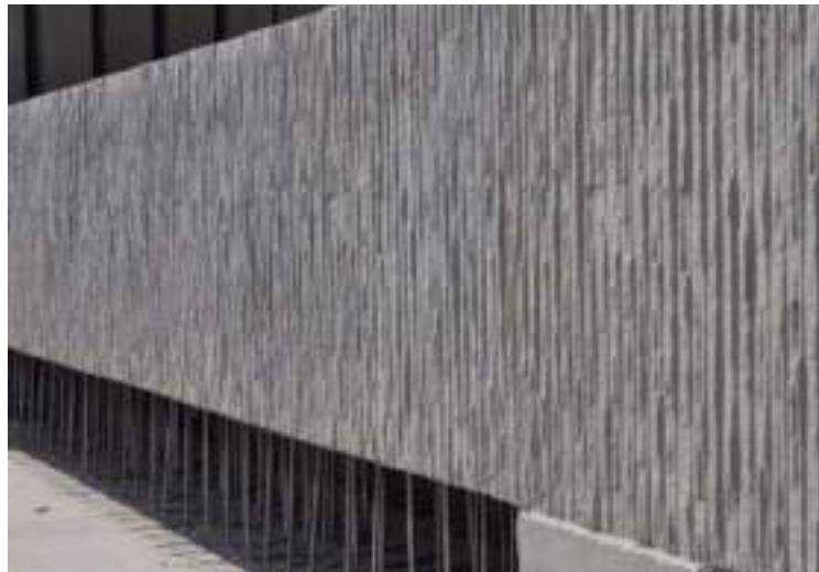
Figura 55. Imatge acabat mur formigó amb encofrat fusta vertical.
