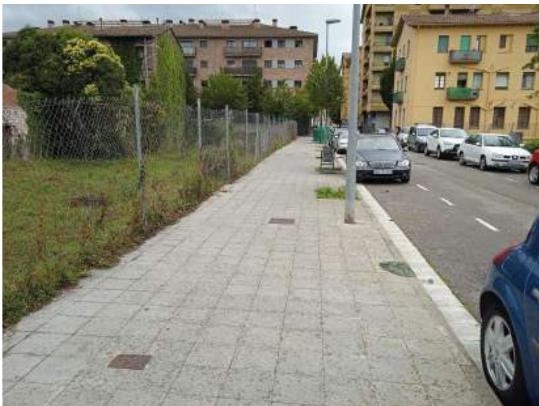
Figura 10. Estat actual del paviment de la vorera del carrer Abat Racimir
