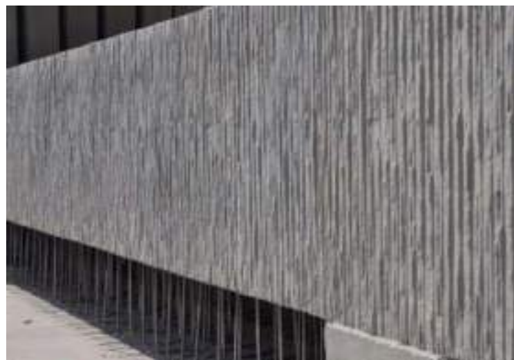
Figura 25. Imatge acabat mur formigó amb encofrat fusta vertical.
