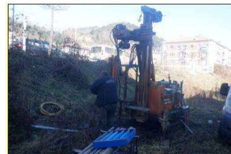
Màquina emplaçada al sondeig efectuat.
