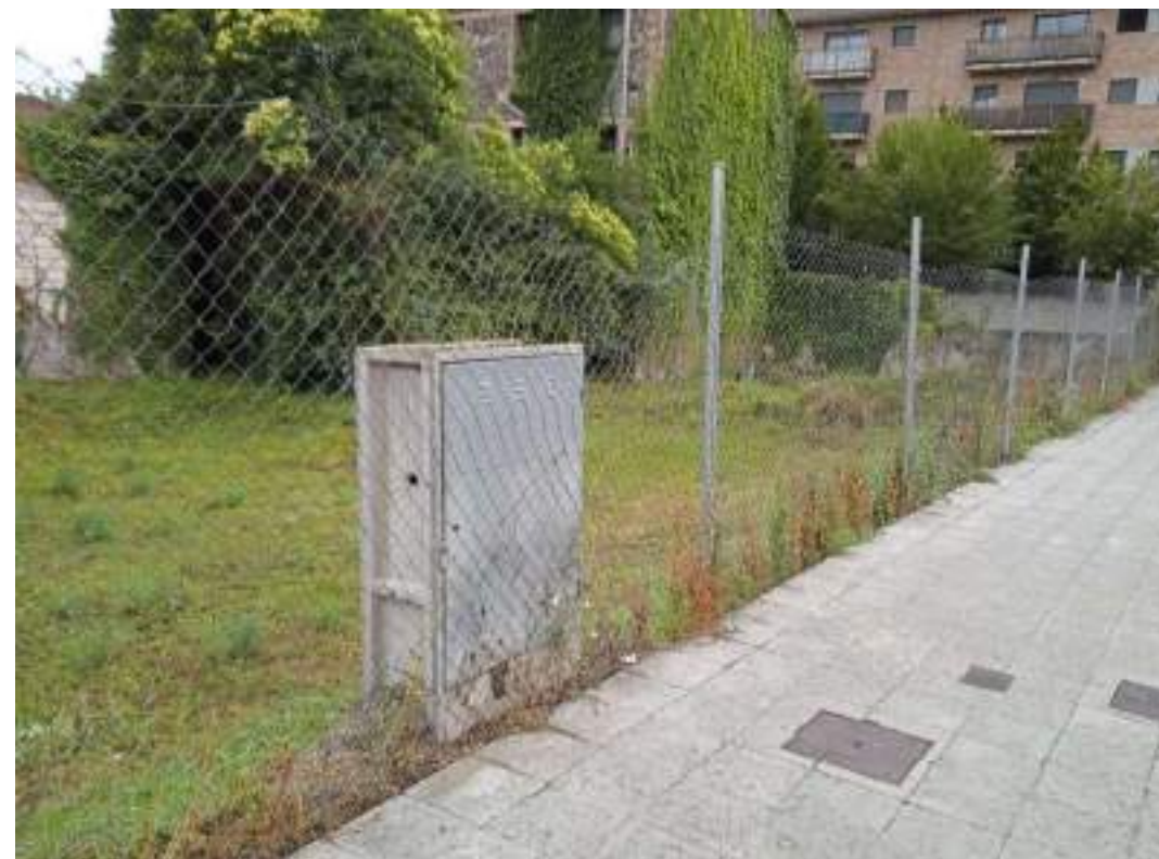
Figura 8. Fotografia armari de baixa tensió existent a enderrocar
