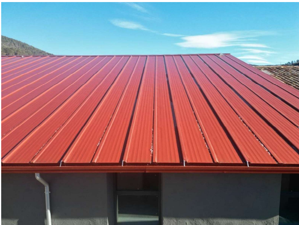
Figura 6. Imatges de la coberta objecte del projecte. Font: elaboració pròpia.
