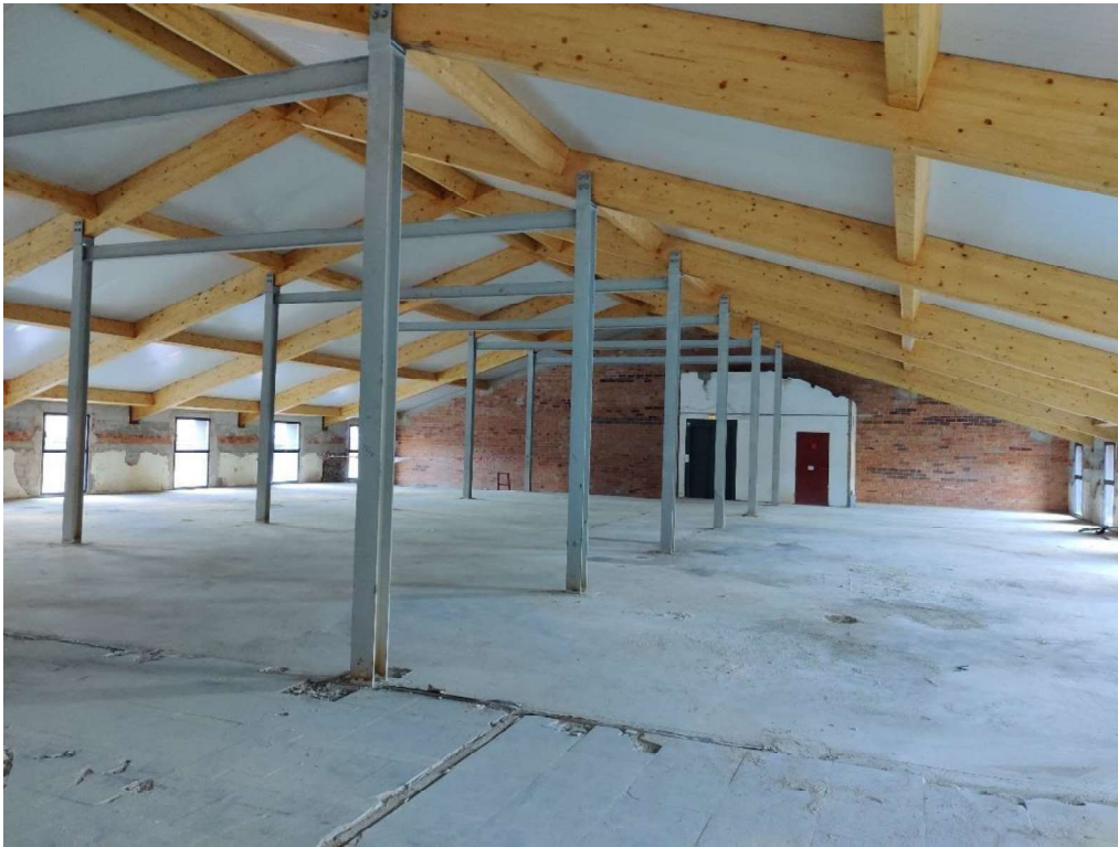
Figura 7. Imatge de l'estructura de la coberta objecte del projecte. Font: elaboració pròpia.
