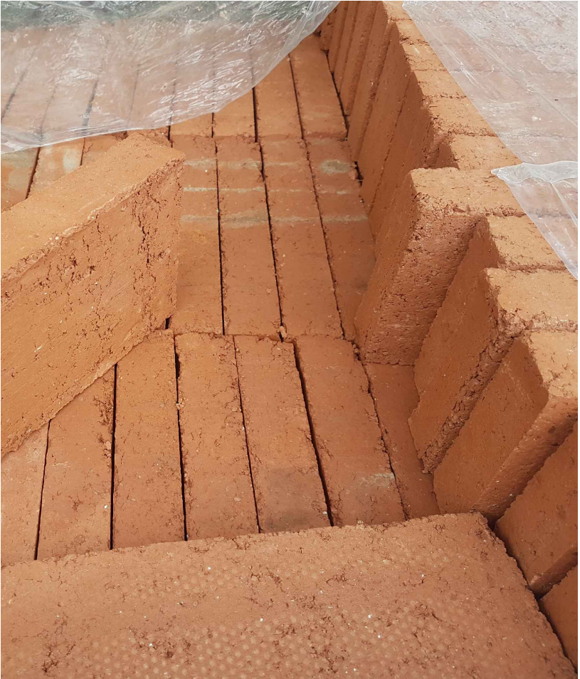
imatges de referència escala escales sobre el talús construïdes a les obres del pas fluvial del riu Sec
