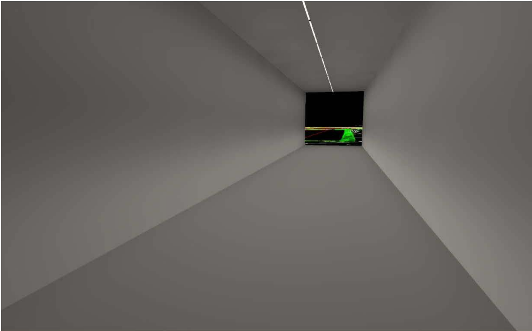
Pas Soterrat N-150
