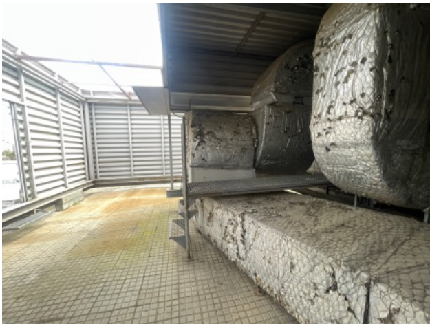
Passarel·les existents a adaptar
