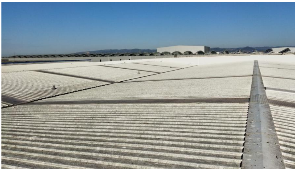
Figura 1: Coberta on instal·lar el camp fotovoltaic
