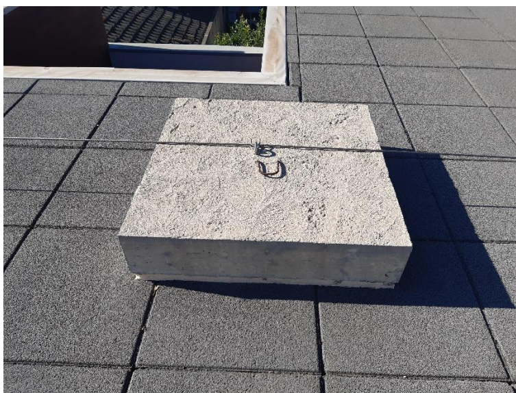
Figura 11. Daus de formigó per al suport de la línia de vida central a la coberta.
