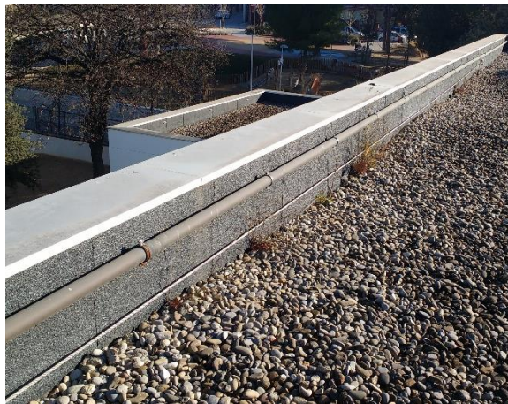
Figura 10. Línia de vida existent a la coberta de grava.
