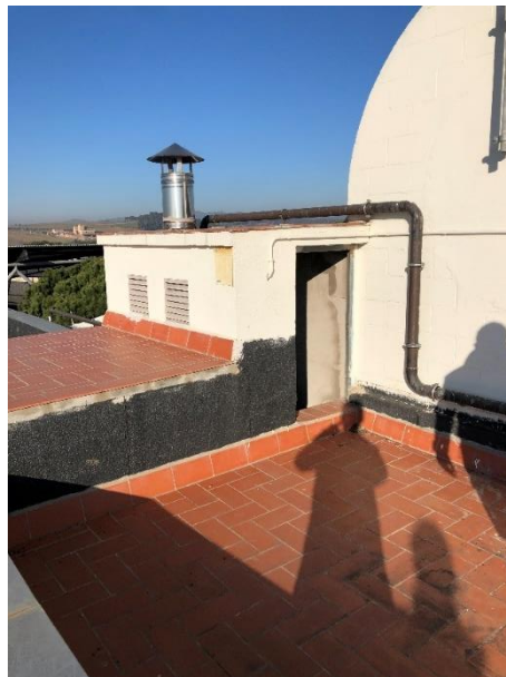
Figura 7. Porta d'accés a la coberta.
