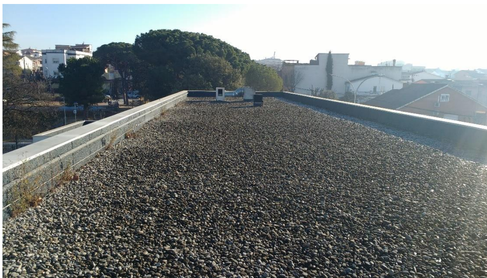
Figura 3. Vista general de la coberta de grava on s'instal·larà el camp fotovoltaic.
