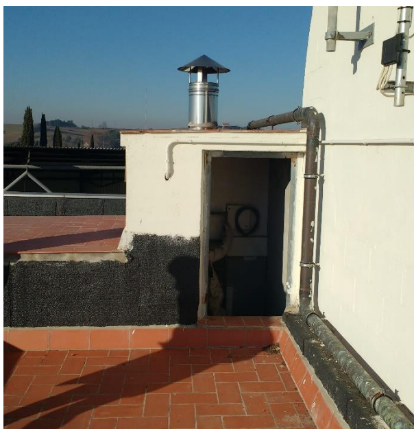
Figura 8. Accés existent a la coberta desde l'interior de l'edifici.
