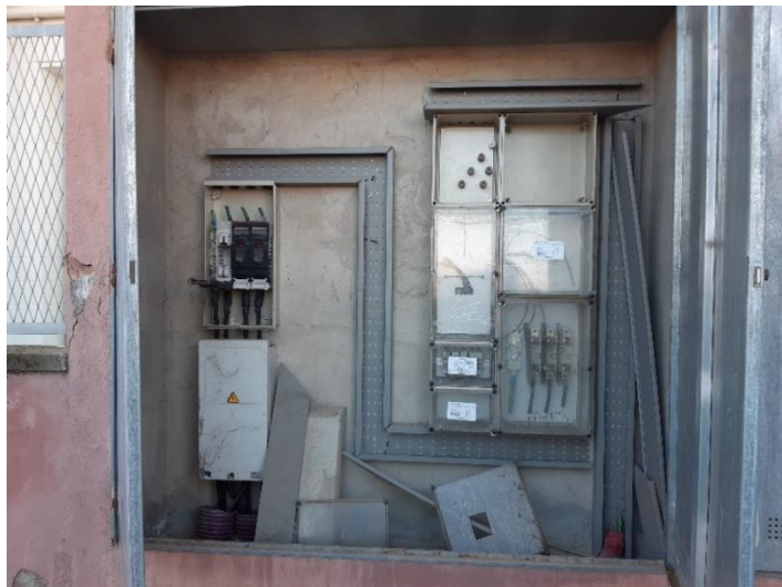
Figura 12. Espai previst per a la ubicació de la nova TMF de consum per a unificar les dues escomeses existents a la instal·lació.
