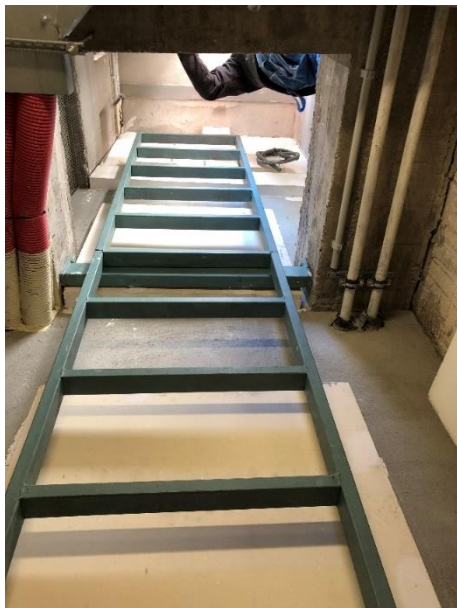
Figura 6. Escala interior d'accés a la coberta.
