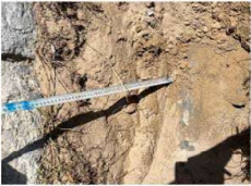
Fotografia 16. Profunditat de la cala 7, on s'ha detectat la sabata del mur del passeig marítim.
