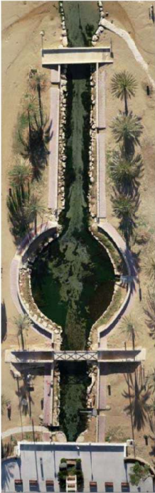
Figura 3.1. Imatge aèria de l'estat actual del Riuet a l'àmbit del projecte.
