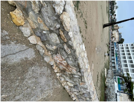
Im. 1.9 – Mur de pedra que conforma el Riuet
