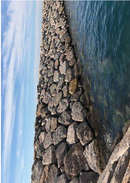
Im. 1.1 – Pedres d'escullera de cantera propera a l'àmbit d'actuació
