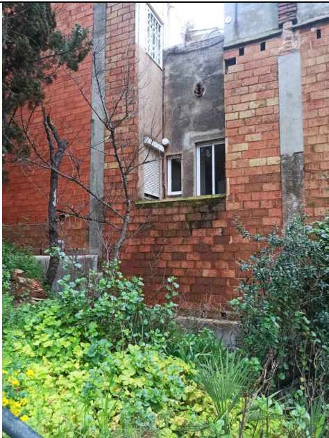
2. FOTOGRAFIA MUR HABITATGE N°76
