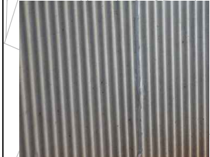
FORMLINER DE FORMIGÓ (MURS 4 i 5)
