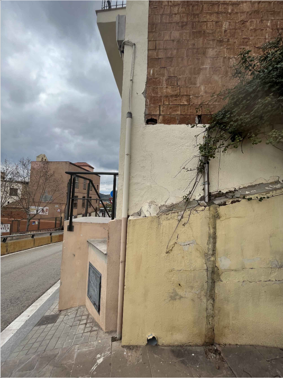
3. FOTOGRAFIA ZONA LATERAL DE L'HABITATGE N°76
