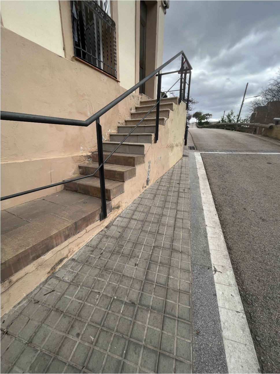
3. FOTOGRAFIA PERSPECTIVA ACCÉS ACTUAL HABITATGE N°76
