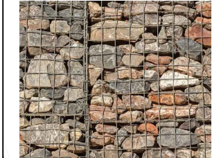
REVESTIMENT DE GABIONS
