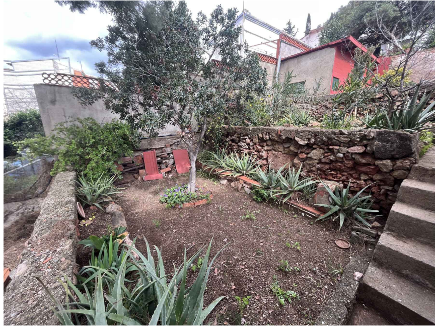
3. FOTOGRAFIA DES DEL SEGON NIVELL. MUR DE CONTENCIÓ
