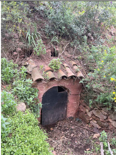
3. FOTOGRAFIA MINA D'AIGUA
