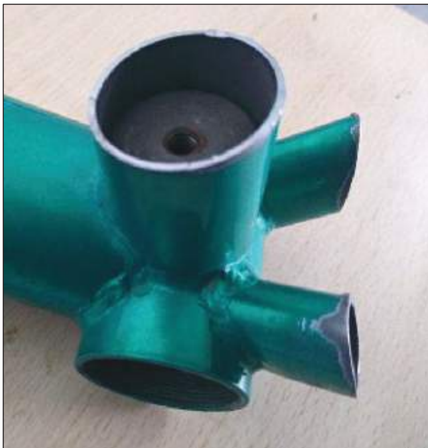
Imatge codi BICI039-04: Fotografia disc soldat a la part superior de la caixa pedaler.
