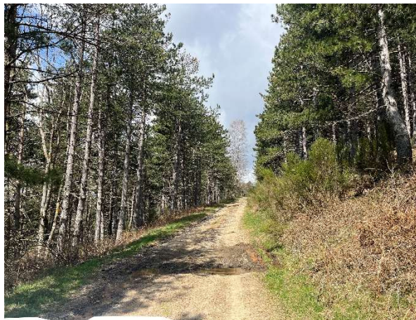
Foto 3: Camí sense drenatge transversal (Font: Montserrat Solanelles Ubach).
