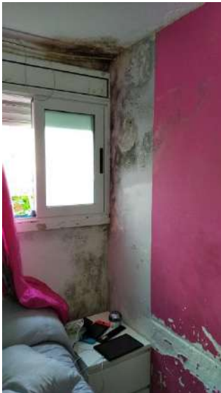
DETALLS FORJAT LLOSA DE FORMIGÓ AFECTADA PER FILTRACIONS D'AIGUA
