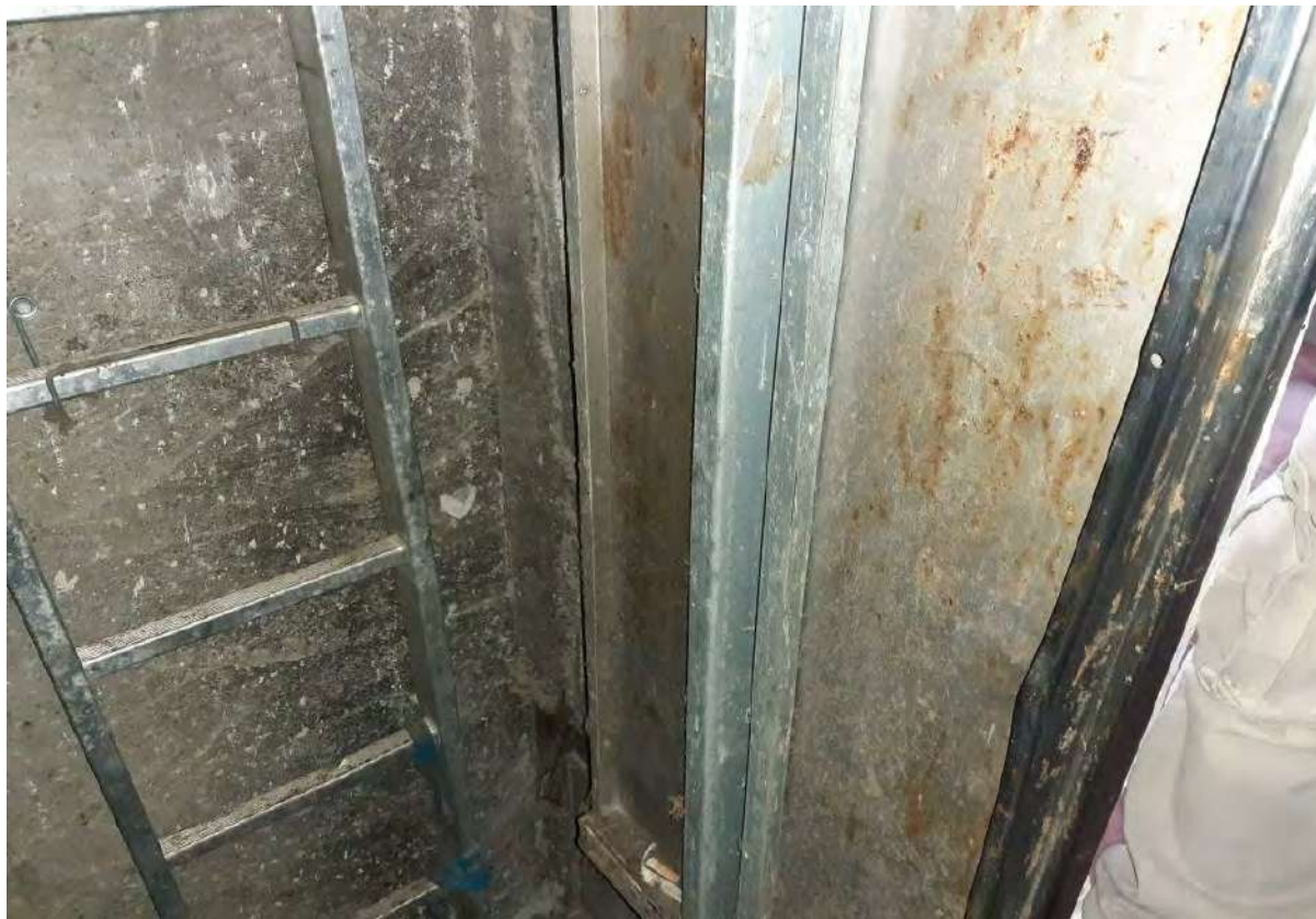
* Vista del panell de façana, per l'interior del ascensor
