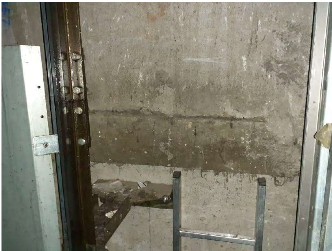
* Vista del panell de façana, per l'interior del ascensor
