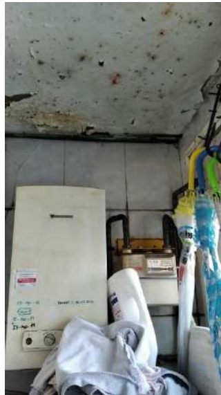
DETALLS FORJAT LLOSA DE FORMIGÓ AFECTADA PER FILTRACIONS D'AIGUA
