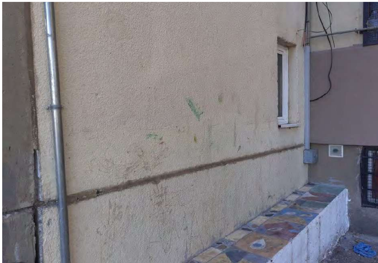
* Vista del panell de façana, part exterior (Carrer)
