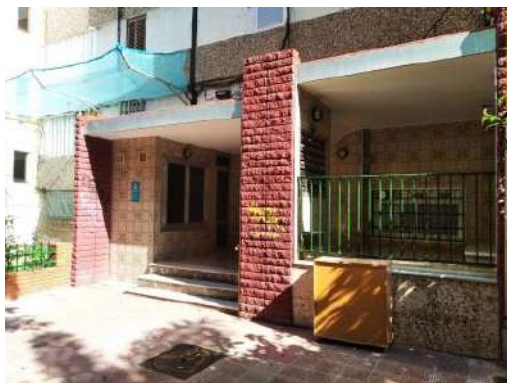
PRE-VESTÍBUL CONSERVAT EN ESTAT ORIGINAL
