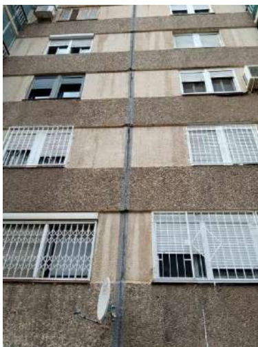
DETALLS JUNTES PANELLS FAÇANA SUD
