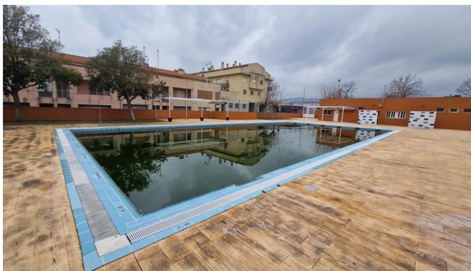
Estat actual de la piscina gran
