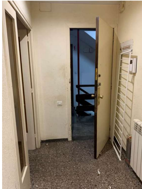
Fotografia 18 – Accés a l'habitatge
