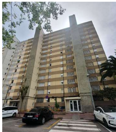
Foto 02. Façana nord de l'edifici al c. Prat núm. 11-13
