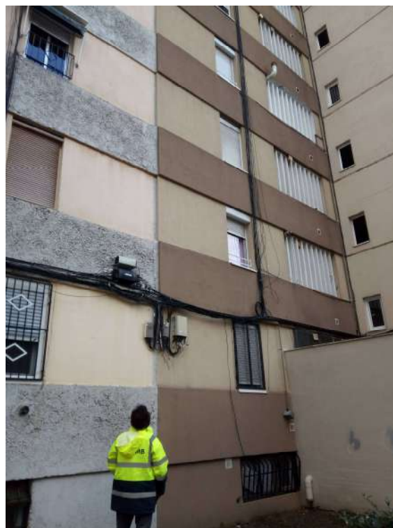
Foto 12. Detall façana aïllada a partir de planta primera
