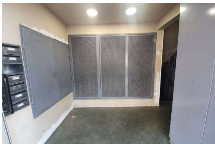
Foto 10. Vestíbul accés nuclis d'escalles
