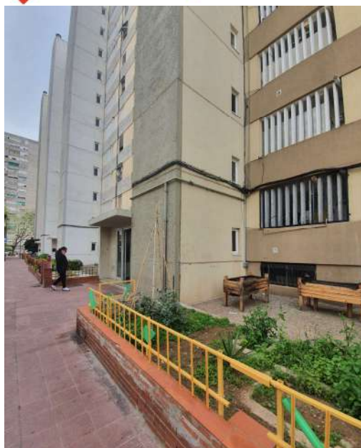
Foto 06. Urbanitz. i nuclis d'escalles de l'edifici del c. Prat núm.13
