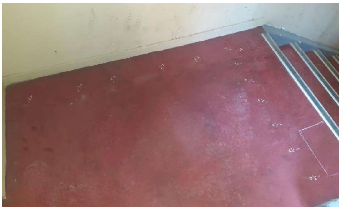
Imatges de les posicions de les armadures detectades amb patxòmetre
