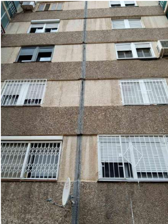
Façana posterior. Detall junta estructural França 32
