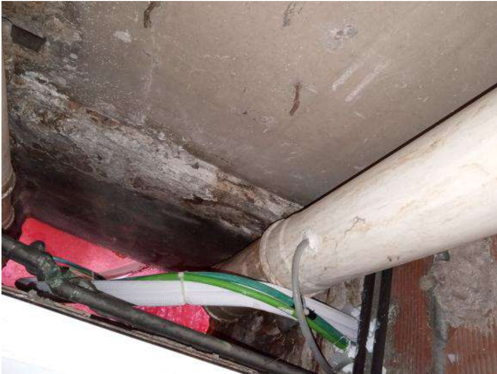
Pati Instal·lacions 13e 2a
