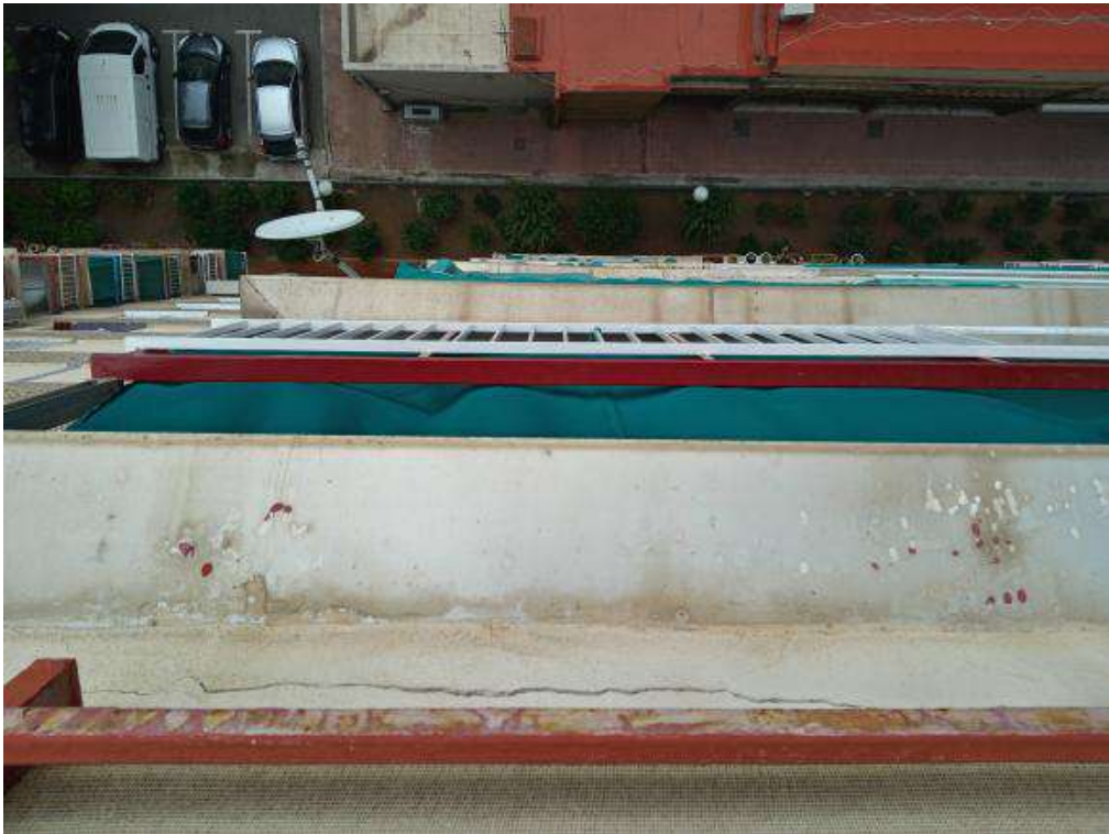
Llosa terra 13e
