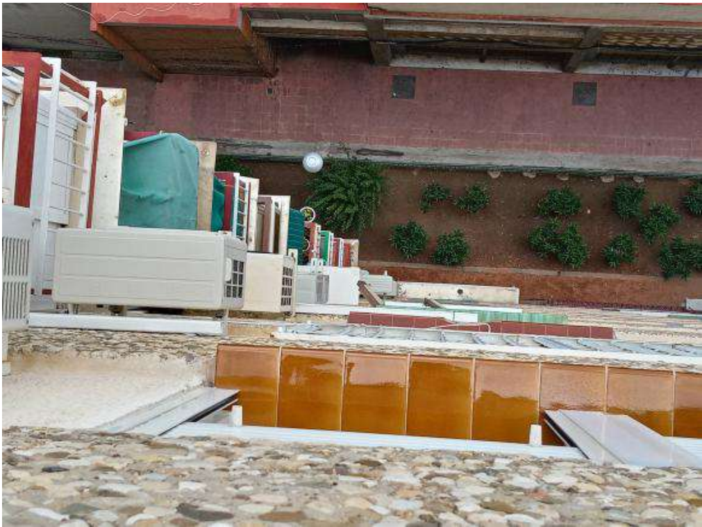
Façana posterior. Detall ampits finestres
