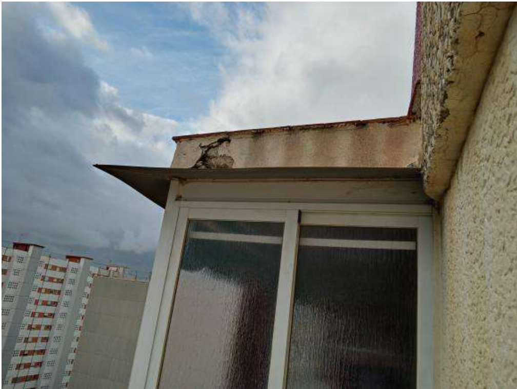
Coberta balcons planta 13e 2a
