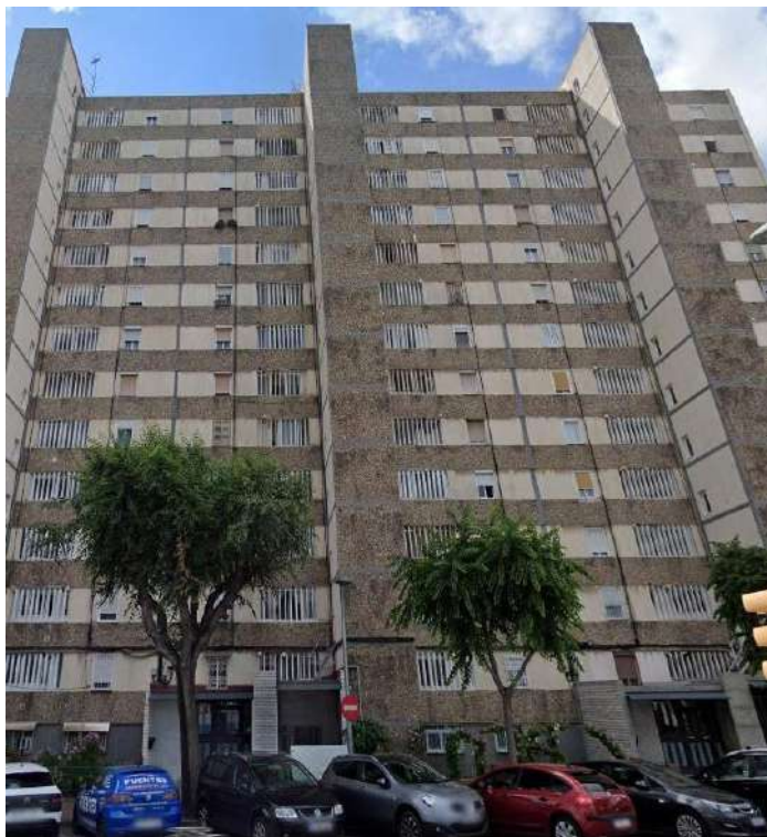
Façana principal. Vista general
