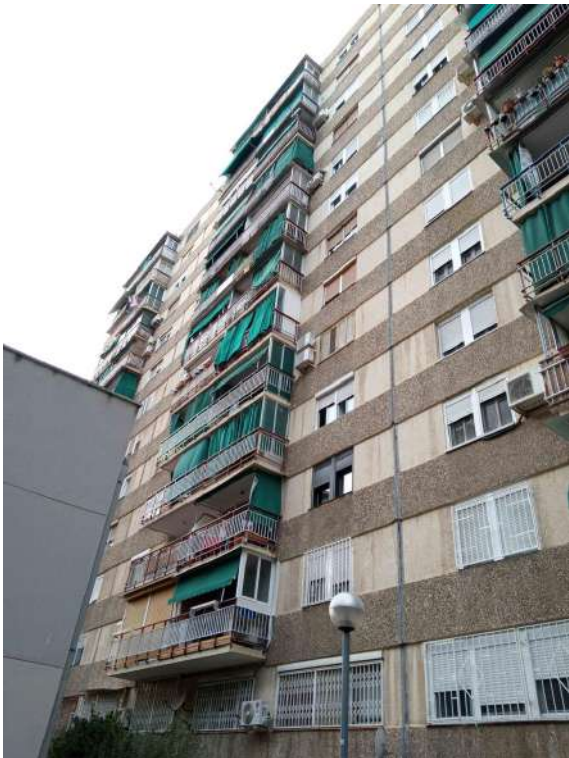
Façana posterior. Vista general
