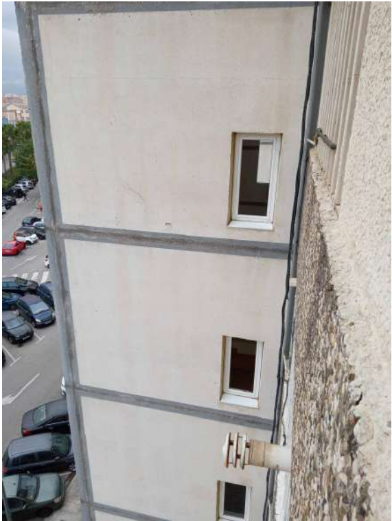
Vista general portes 1a
