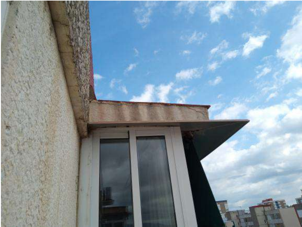
Coberta balcons planta 13e 1a
