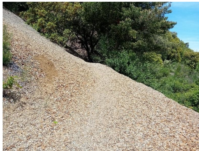
Zona d'abassegaments a la banda esquerra del barranc
