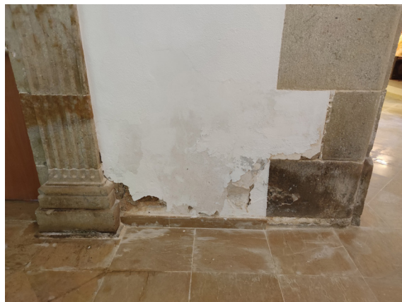
Efecto de las humedades en el Monasterio procedentes de las escorrentías del parque de Monticalvari
