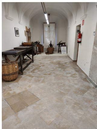
Efecto de las humedades en el Monasterio procedentes de las escorrentías del parque de Monticalvari
