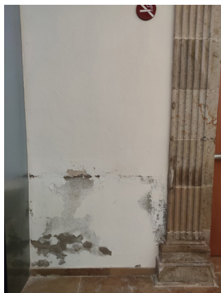
Efecto de las humedades en el Monasterio procedentes de las escorrentías del parque de Monticalvari
