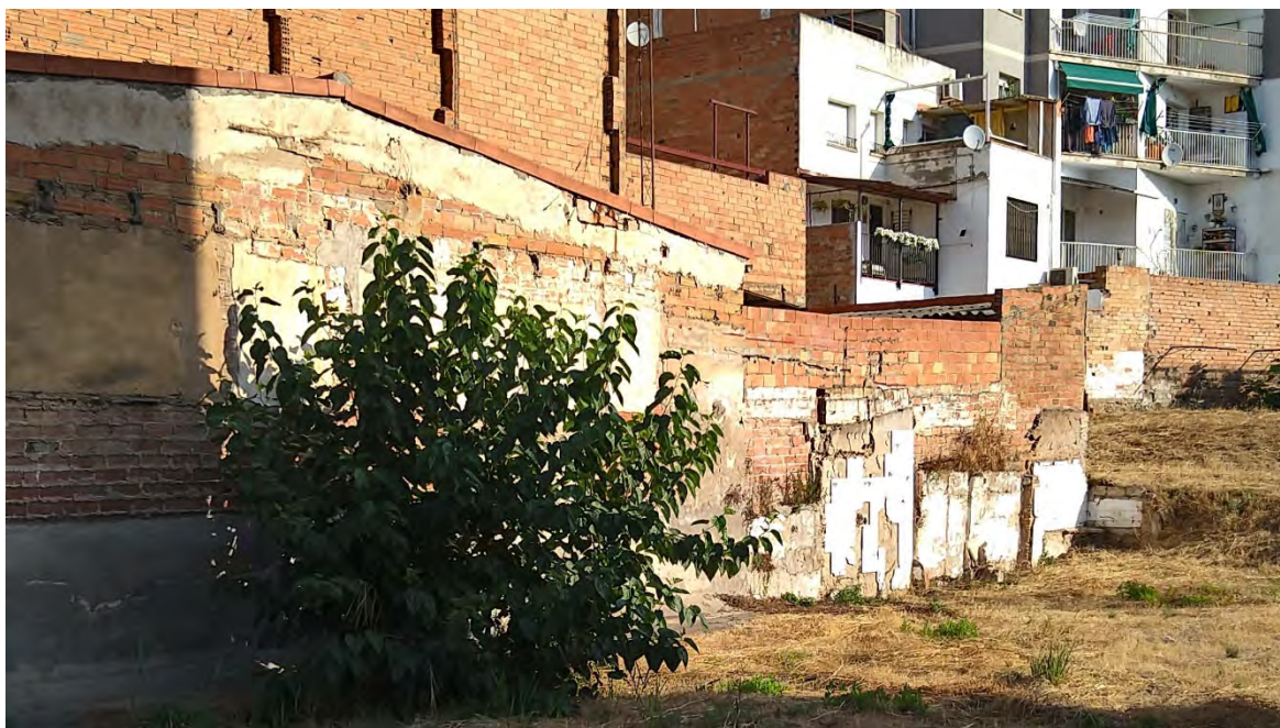
ASPECTE EXTERIOR DE LA FINCA
