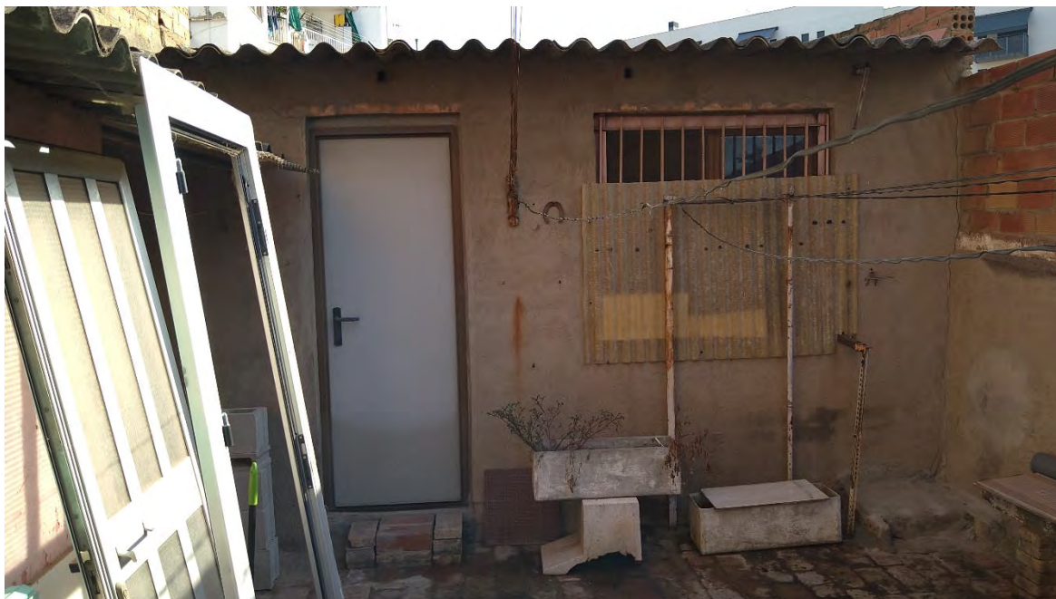
COBERTS AL FONS DEL PATI
