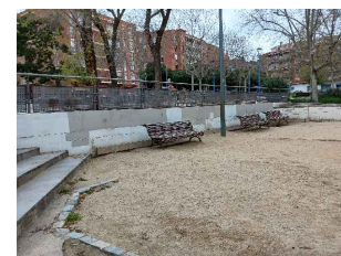
V27 PETANQUES APLACAT/REVESTIMENTS MALMESOS MUR MALMÉS/COBREMUR TRENCAT
