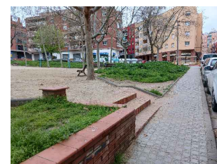
V3 MUR ESQUERDAT/COBREMUR TRENCAT ESCALA/RAMPA SENSE BARANA DEPOSICIÓ SAULÓ SOBRE VORERA
