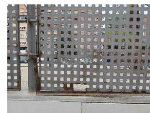
V26 DETALL TANCA TANCA OXIDADA/TRENCADA
