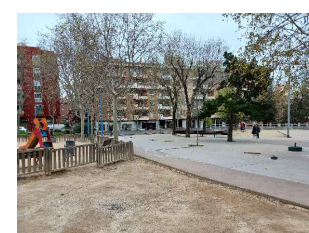
V12 FORMACIÓ DE GRAÓ PER MANCA DE MANTENIMENT PAVIMENT DE SAULÓ PREVISIÓ NOU PROJECTE ÀREA DE JOCS
