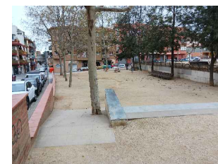
V33 CONNEXIÓ PETANQUES PETANQUES I AJI APLACAT/REVESTIMENTS MALMESOS MANCA ITINERARI ACCESSIBLE
