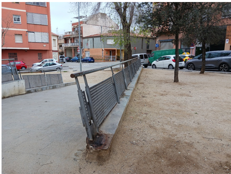
Barana existent rampa
