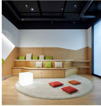
GRADA SOBRE TARIMA. Grada formada amb taulells de contraxapat de bedoll i acabat amb melamina verda. Tarima de fusta formada amb llistons de fusta bisellats i encadellats.
