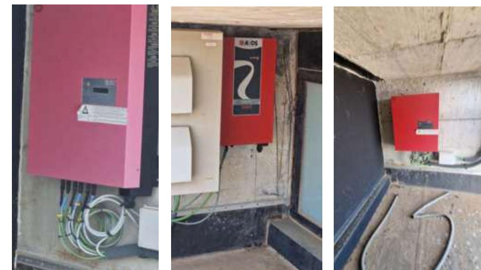
Imatge 78. Imatge d'alguns dels inversors existents
