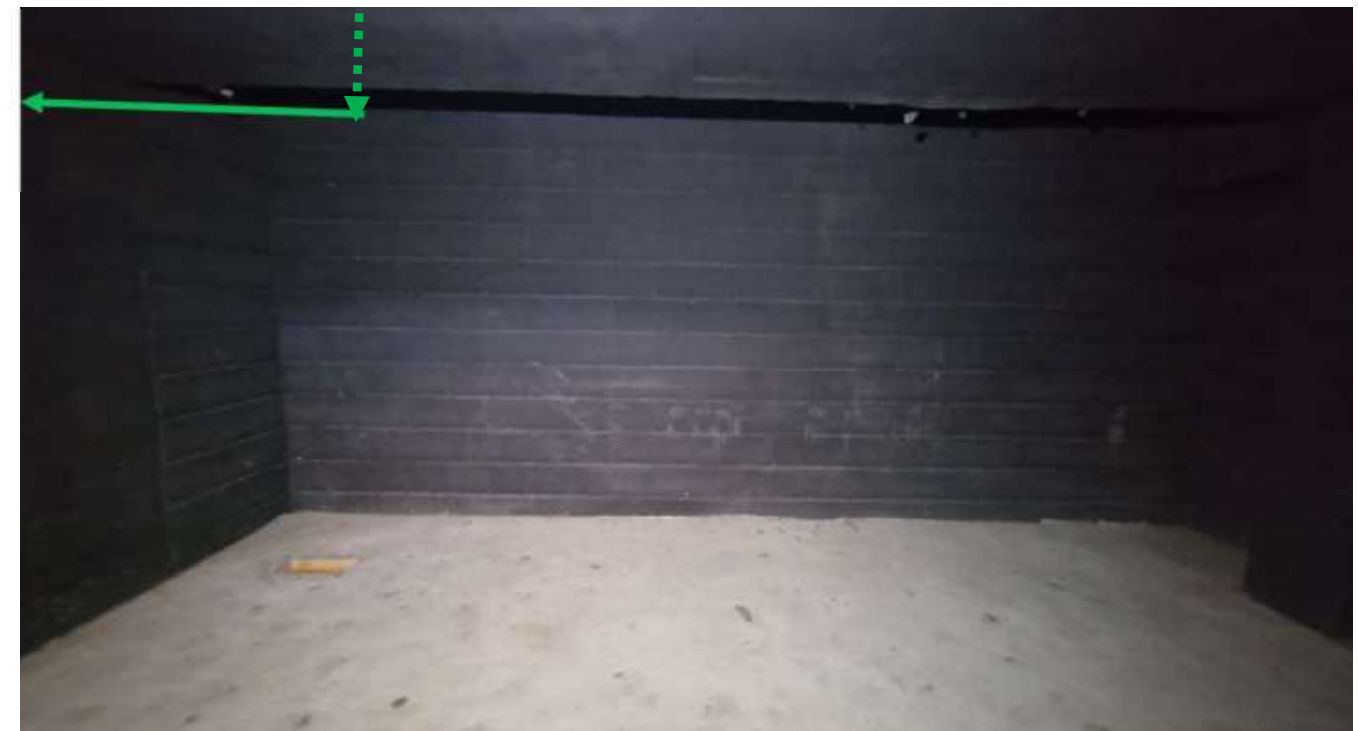
Imatge 67. Paret baixant de coberta fins cota planta baixa
