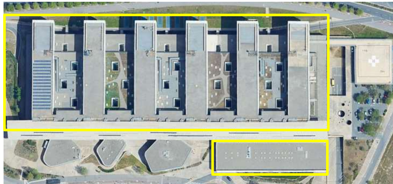
Imatge 2. Imatge aèria zona de treballs
