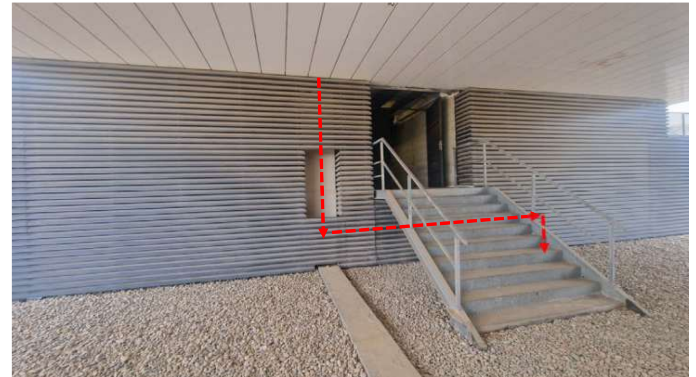
Imatge 51. Pas del baixant de coberta al baixant del soterrani a planta tècnica
