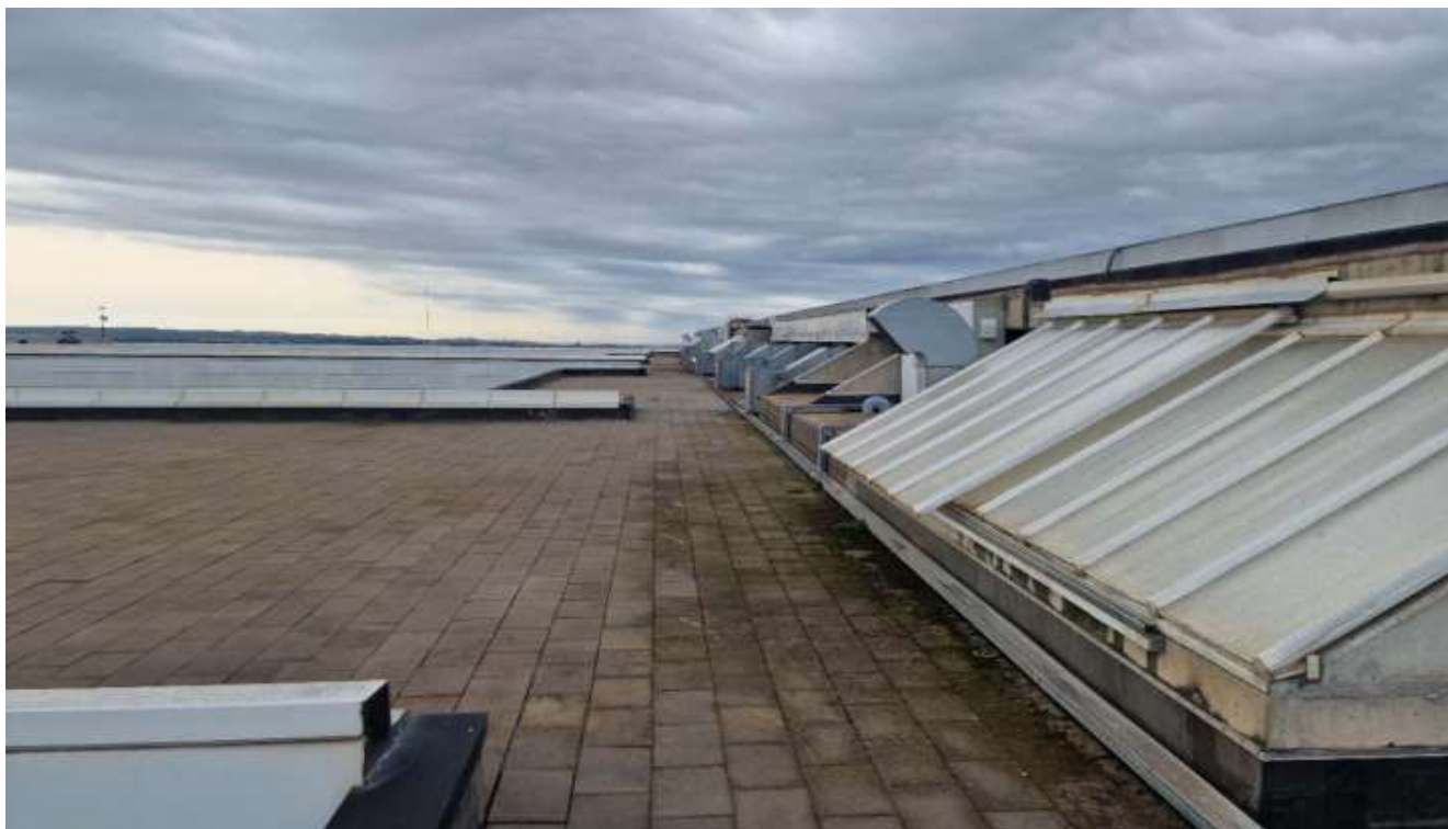
Imatge 2. Imatge coberta, vista Est-Oest
