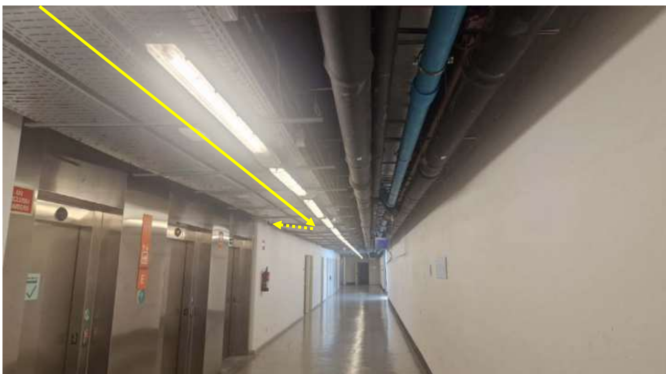
Imatge 73. Cablejat pel passadis nord fins a ET2
