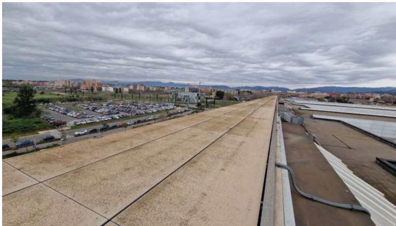
Imatge 5. Zona de la coberta on s'instal·laran els mòduls amb estructures a sud d'una alçada
