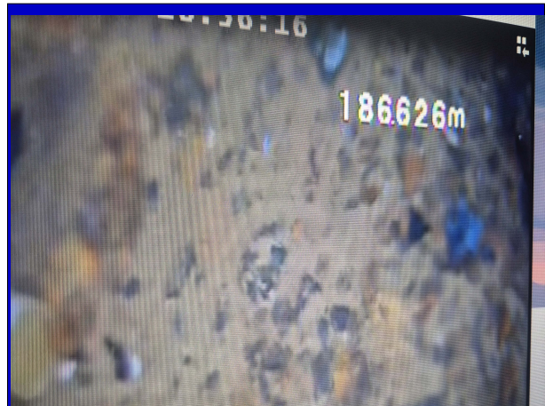
Fotografía: 180a, Nº Video: Video 1, 00:00:00 186m, Fin de la inspección
