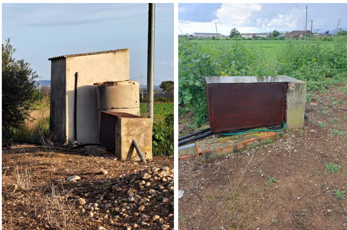
2 Pou 1 de la Carretera (pou existent fora de servei) i caseta de control (emplaçament quadres elèctrics i de telecontrol del pou nou), vista de detall de l'estat actual de l'arqueta del pou existent
