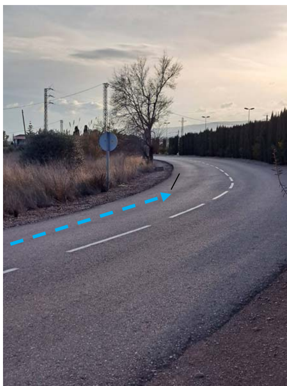
4 Vista general del tram inicial asfaltat del traçat de la nova canonada (PEAD DN-110 mm) de connexió a la canonada existent de connexió del pou nou al dipòsit Polígon Industrial , marcat el traçat previst (marca blava). Tram amb possibles afectacions de serveis existents (xarxa de subministrament elèctric de baixa tensió).
