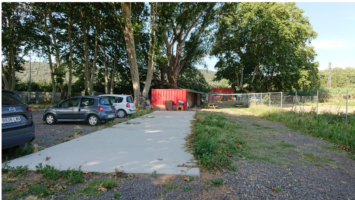
Fotografia 3. Visió direcció oest de la base de formigó existent amb els espais destinats a la connexió de les instal·lacions.
