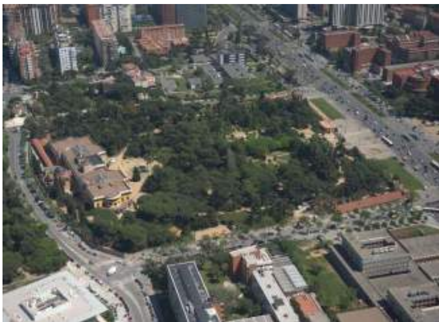
Vista aèria del Parc de Pedralbes. Fotografia realitzada per Jordi Todó, de l'empresa TAVISA (Trabajos de Aviación S.A.) el 23 d'abril de 2009.
