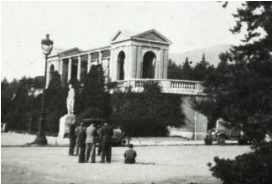
Vista exterior del "pabellón del chofer del Ilte. Sr. Presidente de Cultura", avui Pavelló 3. Fotografia presa per Julio Grau Serrano vers la dècada de 1940.
