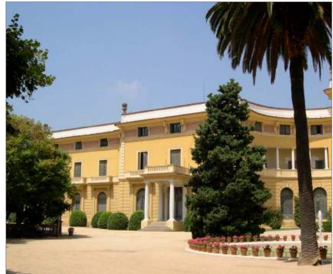
Estat actual de la façana de l'ala més occidental del palau, on es realitzarà la primera fase de les intervencions previstes per la Generalitat de Catalunya.
