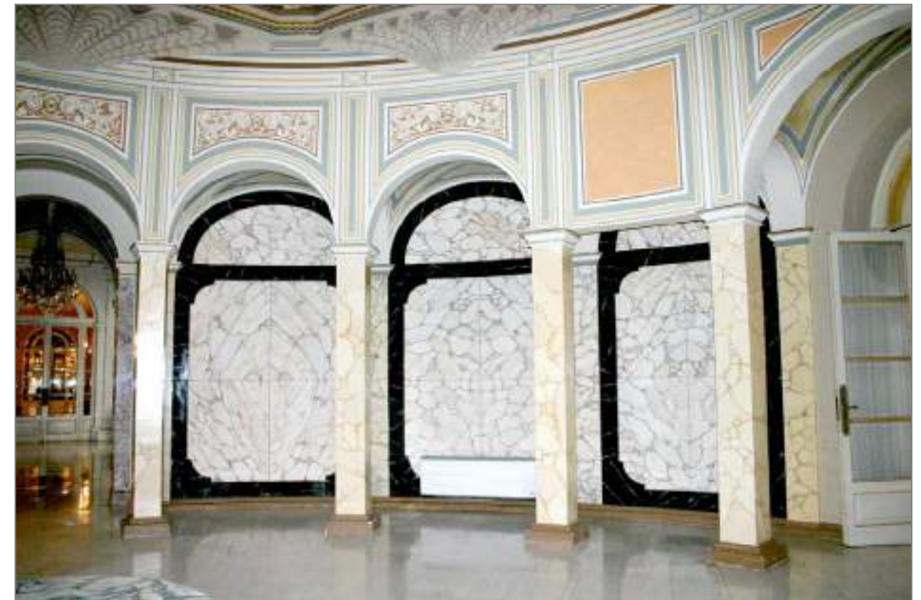
Imatge de l'estat actual de la rotonda, després de la restauració duta a terme el 1998 que va recuperar la circulació per la galeria i el pintat dels murs i pilars imitant marbres de color.
