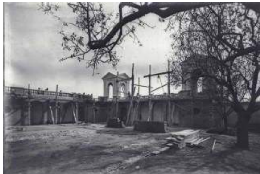
El pavelló 3 en la seva fase inicial de construcció, l'any 1924.
