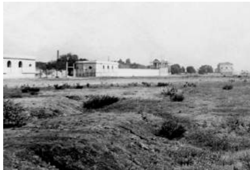
Vista de les obres de la tanca, els cossos de guàrdia i les pèrgoles angulars del Palau Reial. Fotografia sense datar de Josep Brangulí (c.1924?).
