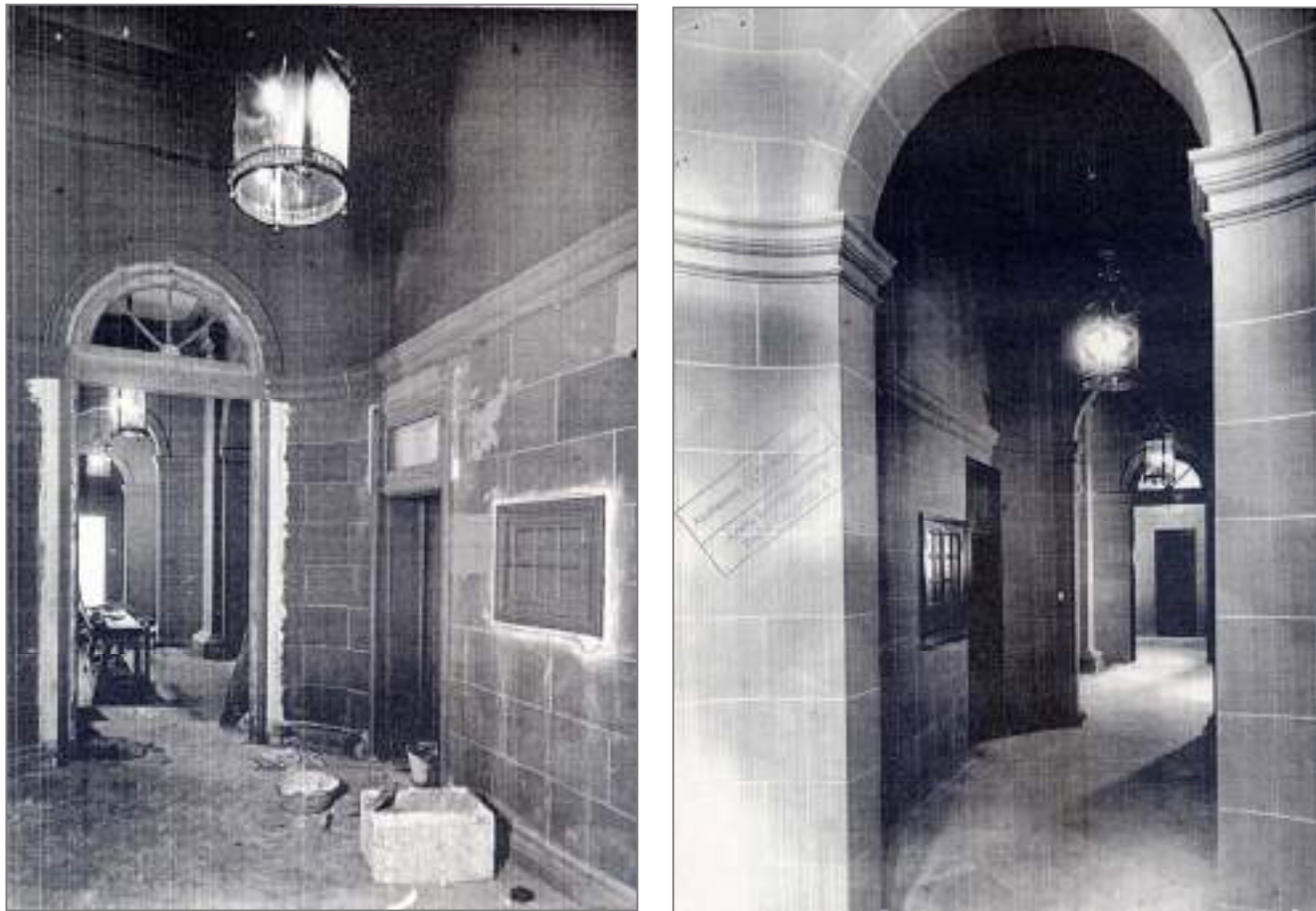
Dues imatges de les obres de modificació dels accessos del corredor realitzades l'any 1948. A l'esquerra mentre s'executaven els treballs i a la dreta un cop aquests van acabar (AMA, Foment interior, exp. 1204)
