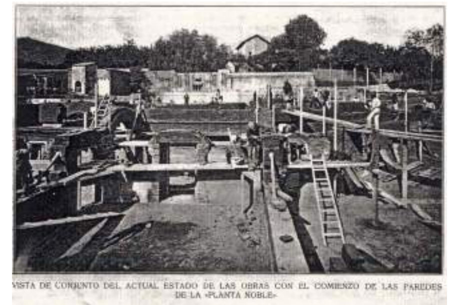
Les imatges del butlletí són valuosíssimes, no tan sols per la curiositat que poden generar pel que fa als mètodes de treball del moment, sinó perquè rebe·len les tècniques constructives emprades en la seva edificació, bàsicament fàbrica de maó disposat de pla a trencajunts.
