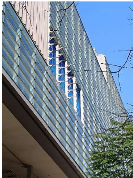
Façana principal (estat actual)
