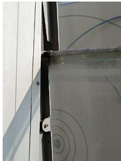
Detall: Junta d'estanquetat
