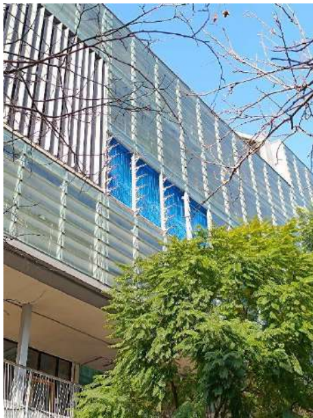
Façana principal (estat actual)
