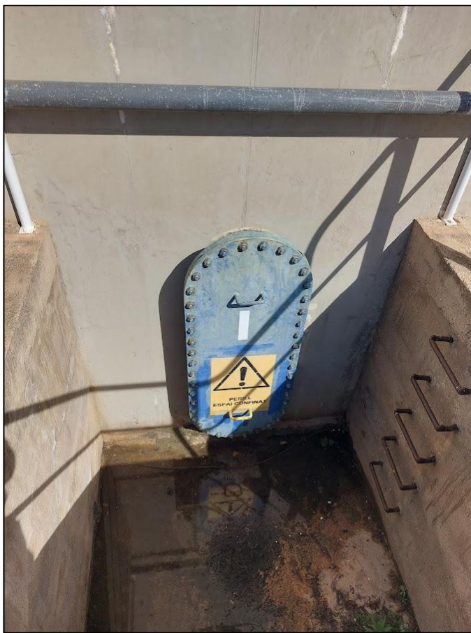
Imatge 3. Boca d'home entrada dipòsit
