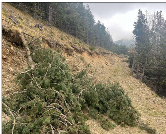
Foto 3: Talús superior inestable a reperfilar (Font: Montserrat Solanelles Ubach).
