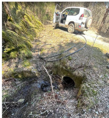
Foto 6: Tub de drenatge del camí a netejar (Font: Montserrat Solanelles Ubach).
