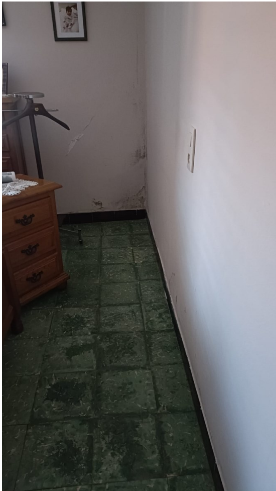
Humitats a la paret mitgera de l'habitatge del carrer del Pont 73. Planta baixa
