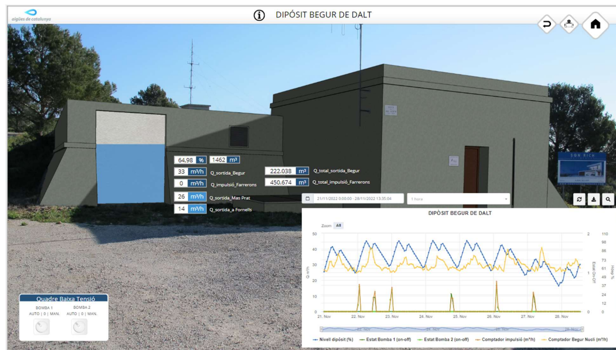
Imatge 11. Telecontrol dipòsit Begur de Dalt
