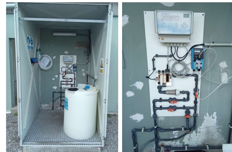
Imatge 9. Interior caseta de cloració
