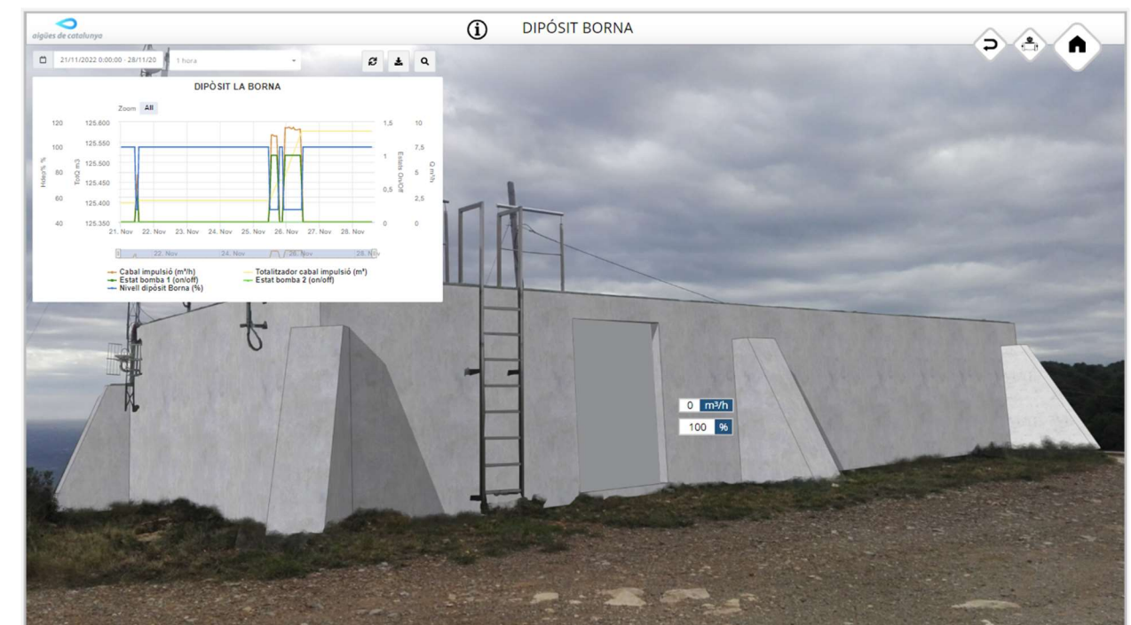
Imatge 29. Telecontrol dipòsit La Borna
