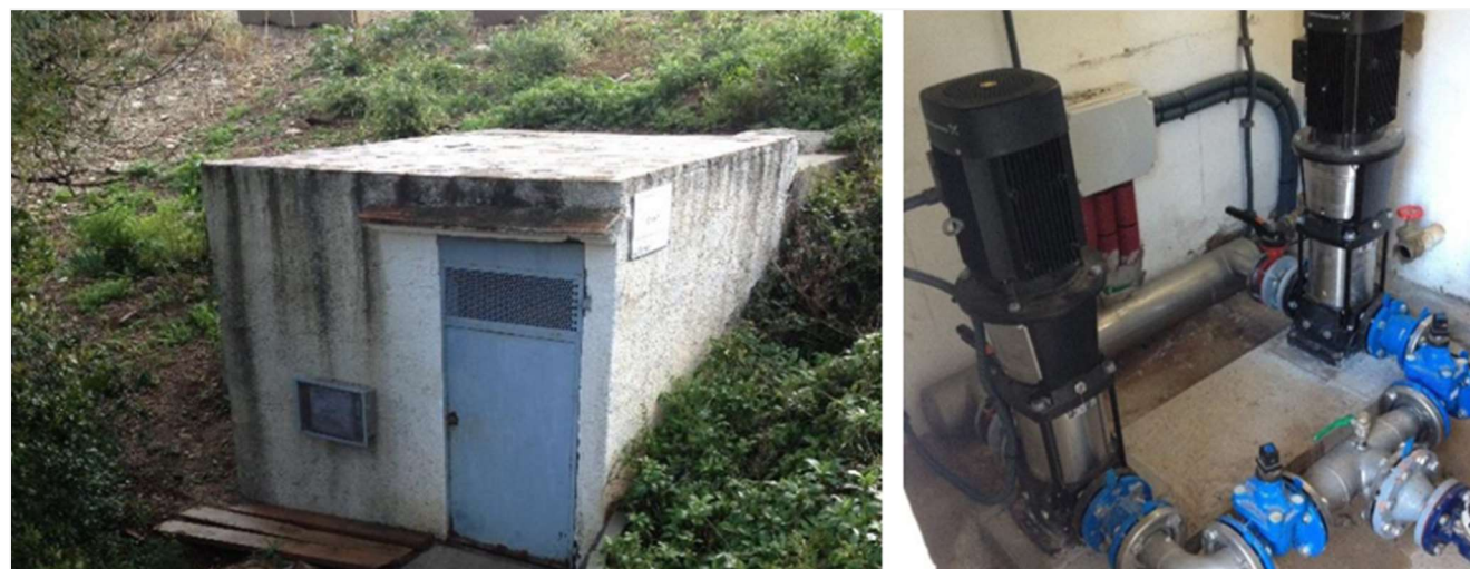
Imatge 18. Vista exterior i interior de l'estació de bombament Farrarons
