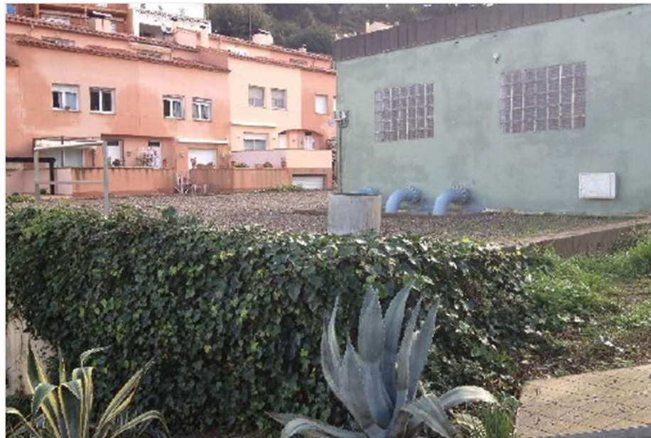
Imatge 7. Dipòsit Begur Intermig
