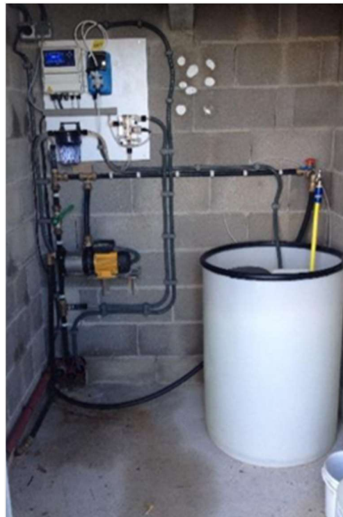
Imatge 21. Interior caseta de cloració
