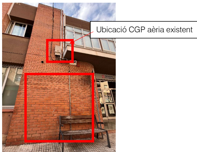
Figura 18 Ubicació del nou armari a instal·lar amb la TMF10 de producció i la CDM
