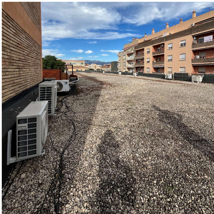
Figura 4 Edifici objecte d'obra fotovoltaica
