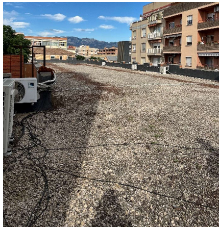
Figura 6 Coberta de grava
