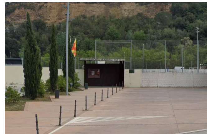
Accés principal personal d'obra
