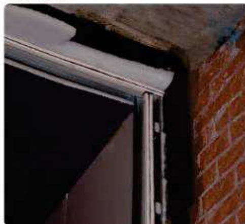
Trasdosado y techo aislante con LA.
