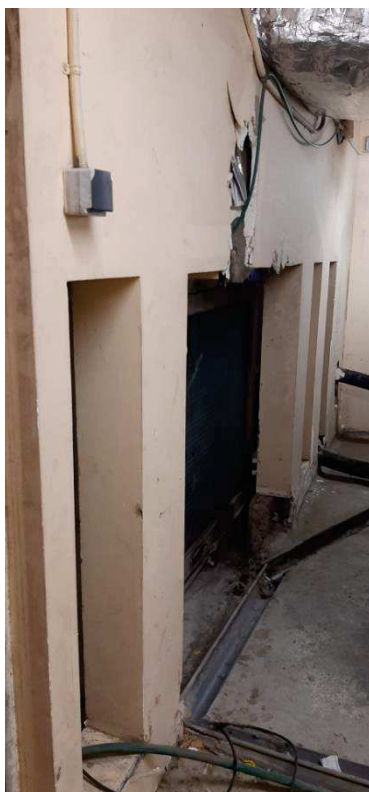
Paret interior local tècnic a enderrocar.
