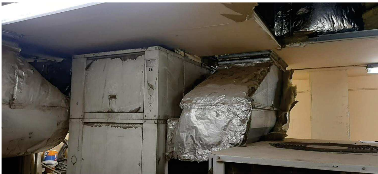
Vista de l'interior del local tècnic.
