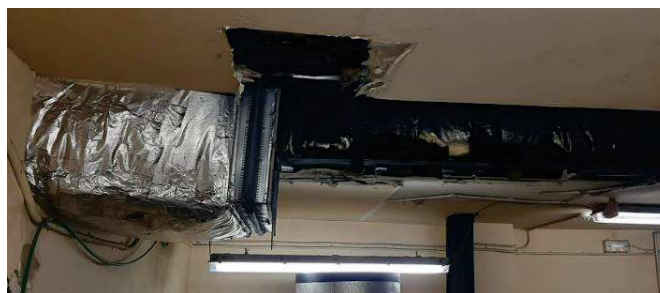
Vista del fals sostre, conductes i instal·lació il·luminació de la sala a demuntar.
