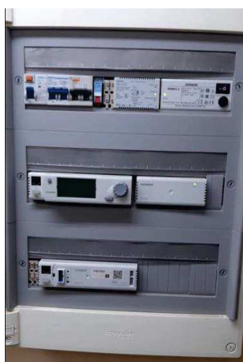
Interrupor general alimentació de la refredadora aire/aigua
