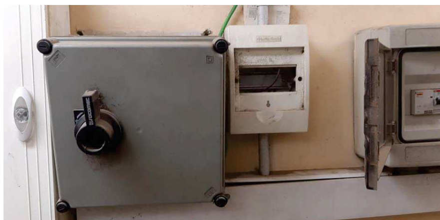
Interrupor general alimentació de la refredadora aire/aigua
