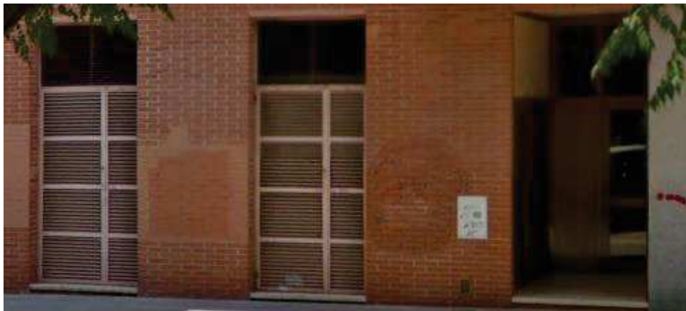
Complex de Formació de Martorell. Portes d'accés al local tècnic màquines de clima.
