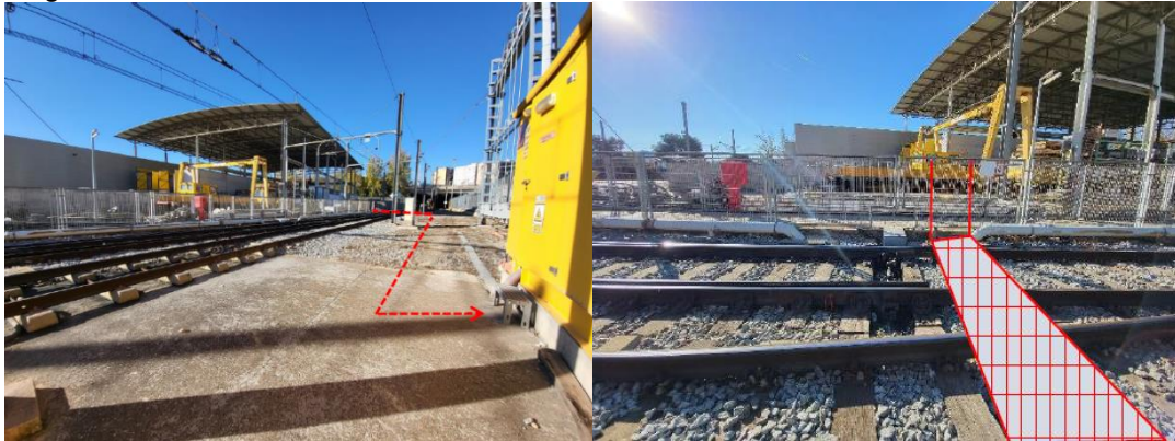
Imatge 10 Accés Subestació Rubí
