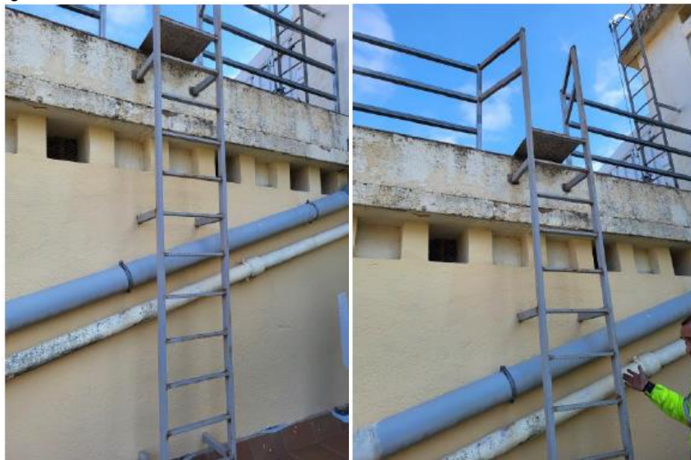
Imatge 6 Accés coberta intermitja St.Cugat
