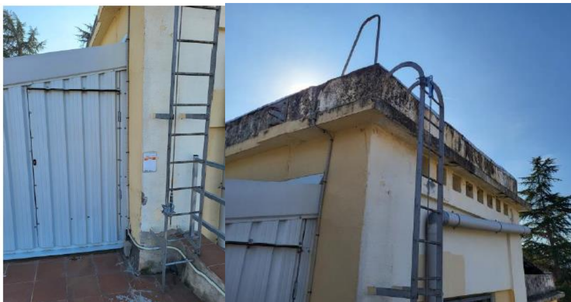
Imatge 7 Accés coberta superior St.Cugat
