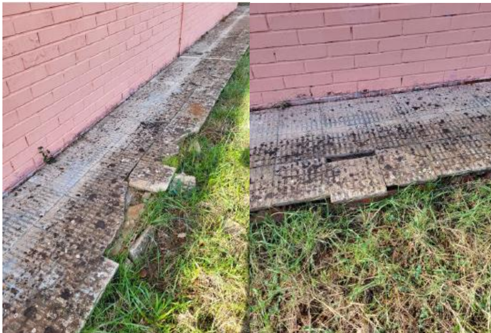
Imatge 22 Paviment perimetral Les Fonts
