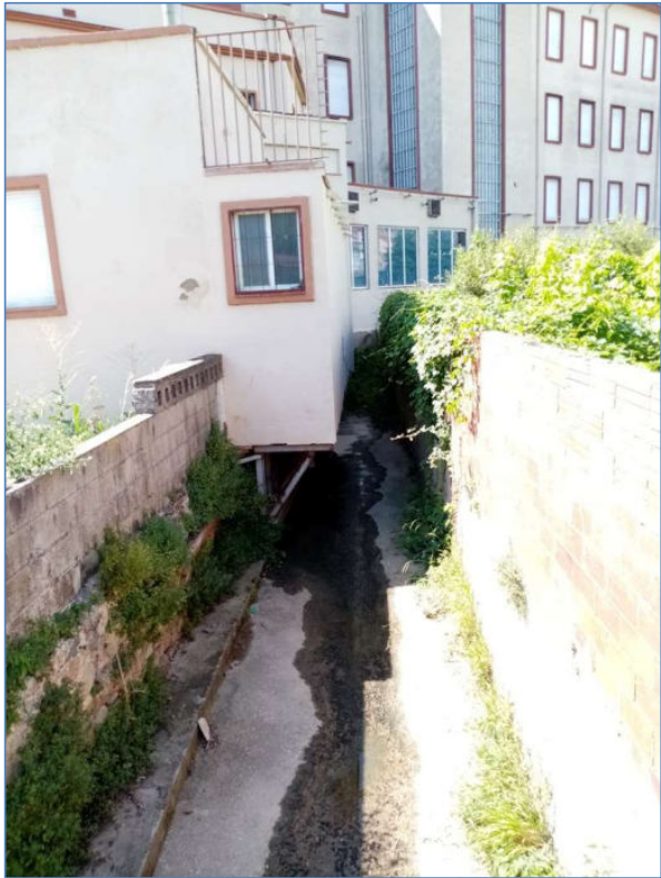
Imatge 4: Tram formigonat
