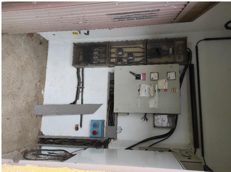
Fotografia 9: Quadres de control de les bombes dels pous Nou i Vell.
