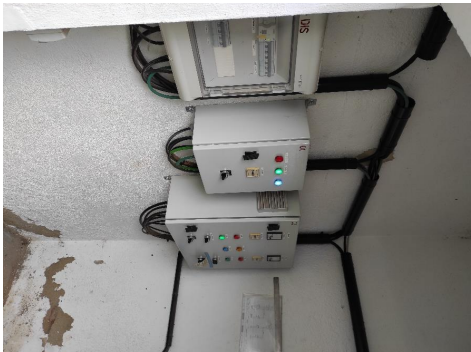
Fotografia 7: Quadres de potència i control de les bombes de la caseta.
