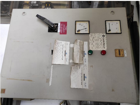
Fotografia 9: Quadres de control de les bombes dels pous Nou i Vell.
